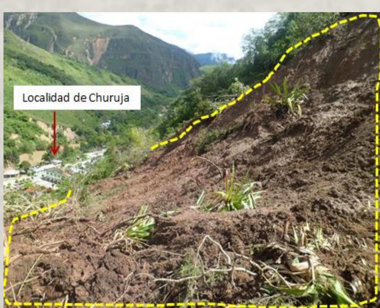
Foto 02: Deslizamiento en la ladera SE del Cerro Tiaranta que afectó a la población de la localidad de Churuja, Fuente: Municipalidad Distrital de Churuja, Abril-2013.
