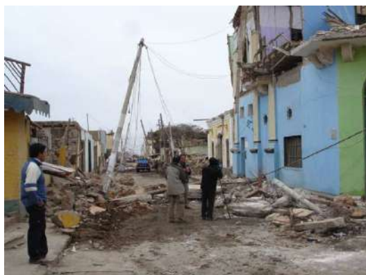
Viviendas de adobe y quincha ubicadas entre las Avenidas José de San Martín con Manuel Pardo, Pisco Playa; con daño nivel 5 (colapso) y nivel 4 (destrucción parcial)
