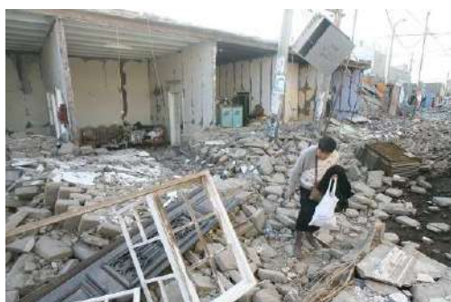
Daño Clase 5 - Pisco
