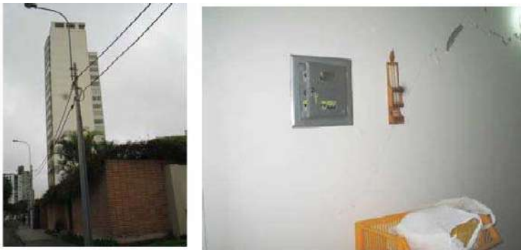
Figure 27.- Tabique hecho con ladrillo pandereta.
