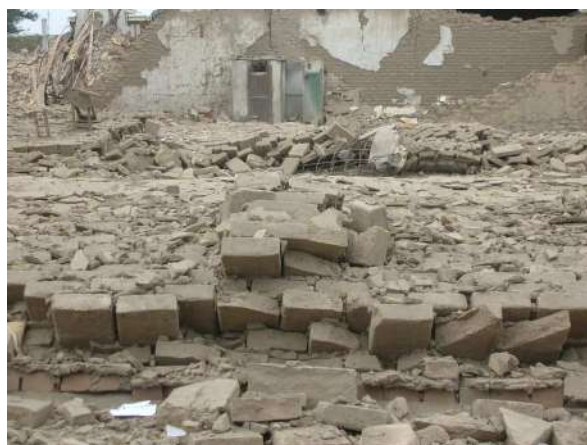
Figura 2.- Muestra de la baja adherencia en las construcciones de adobe.
