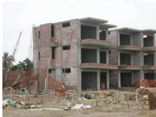
Construcción de Albañilería de 3 pisos- Paraca
