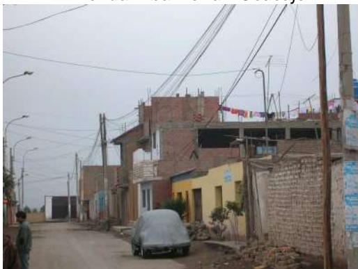
Vivienda Albañilería - Mala
