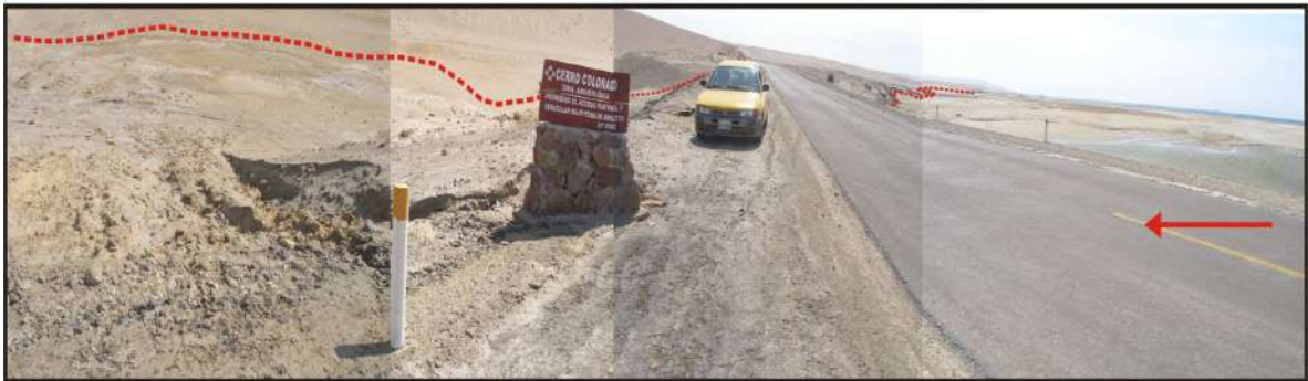
Foto 23: Pista que conduce a la Reserva Nacional de Paracas, en donde se observa el desplazamiento del agua, por encima de la misma.
