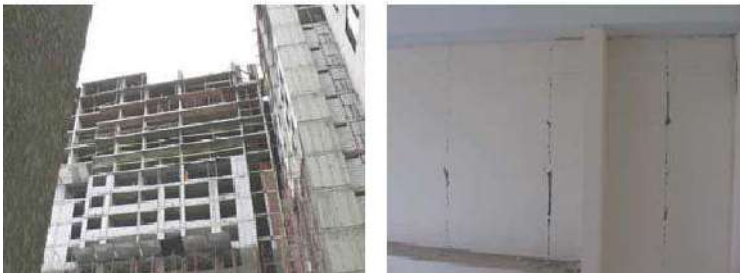
Figure 28.- Tabique hecho con el sistema P-7.
