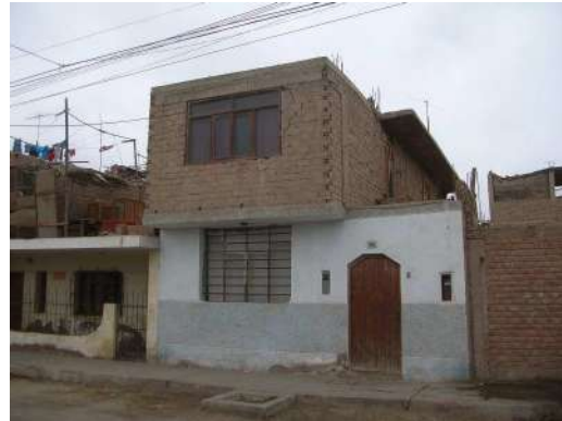
Tabique de fachada en voladizo - Ica
