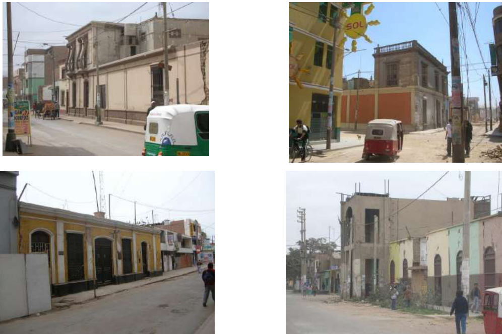
Figura 3.- Viviendas de adobe en sectores urbanos
