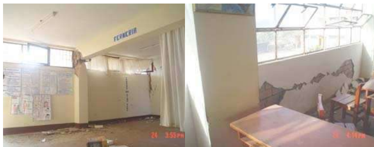
Figura 17.- Instituto Tecnológico de Pisco. Pabellón de 2 pisos (izquierda) y Pabellón de 3 pisos, con columnas robustas (derecha).
