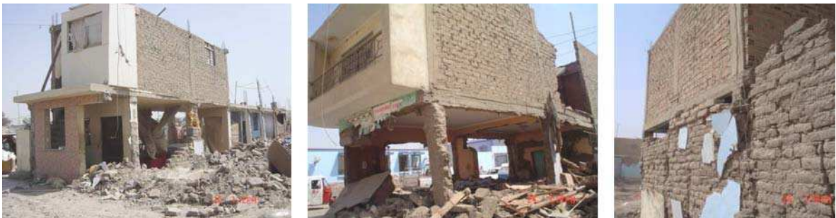
Figure 13.- Primer piso de adobe y segundo piso de albañilería. Pisco.
