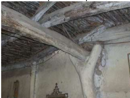
Detalle estructura postes y vigas
