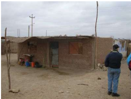
Vivienda Albañilería - Ocucaje
