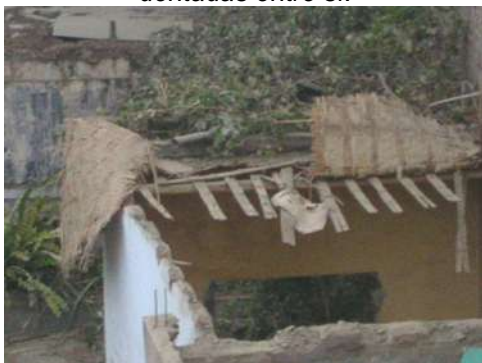
Detalle apoyo techumbre
