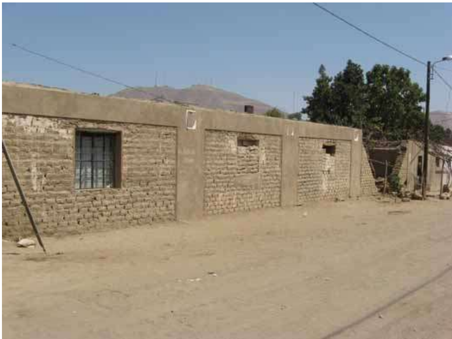
Figura 3.- Esta casa de adobe sin daños fue reforzada con bandas de alambre cubiertas con una mezcla de arena y cemento. Las bandas verticales fueron puestas en cada intersección de la pared, y las bandas horizontales al nivel del techo. A la derecha, nótese el colapso de la pared sin refuerzo.
