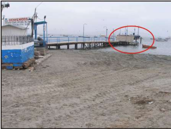
Foto 14.- Muelle levantado por el tsunami a una altura de 3.40 m.
