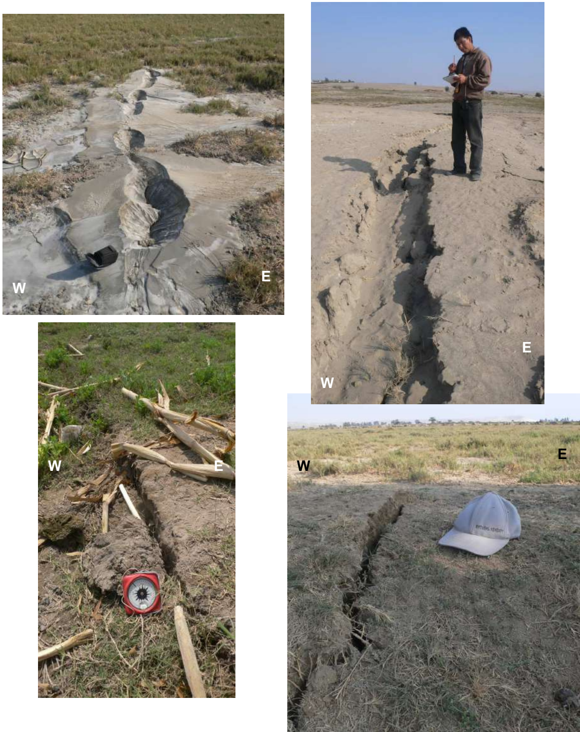
Figura 37.- Imagen superior izquierda: Volcanes de barro formados por licuefacción de suelos con orientación NS. Otros: Ejemplos de desplazamientos verticales alineados en dirección NS; es decir, coherente con la flexura de Huamani (San Clemente).
