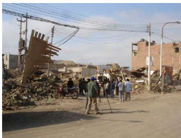
Esquina. Av. San Francisco con Calle San Juan de Dios
