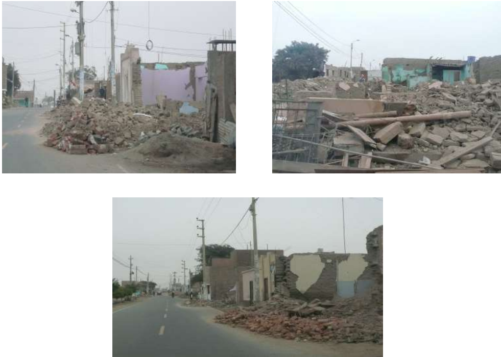
Figura 5.- En Cañete, Tambo de Mora, Pisco e Ica, muchas de las casas de adobe colapsaron.
