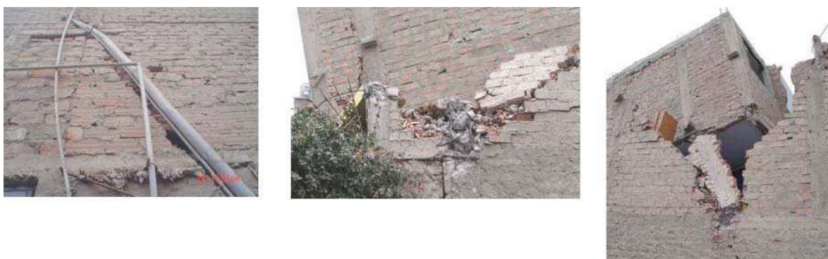
Figura 8.b.- Ladrillo pandereta en Pisco.
