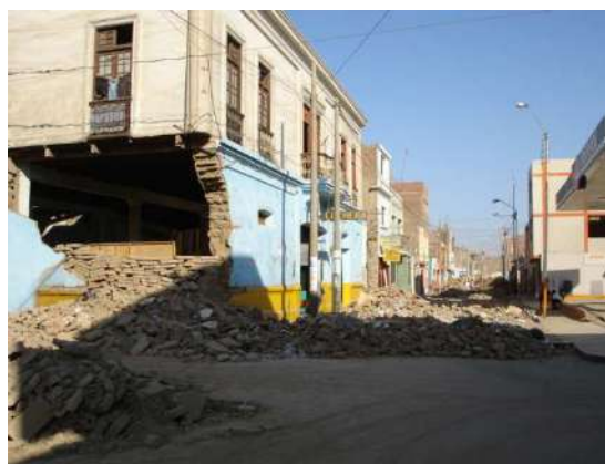
Vivienda de adobe dos pisos, ubicada en la Calle La Mar.
