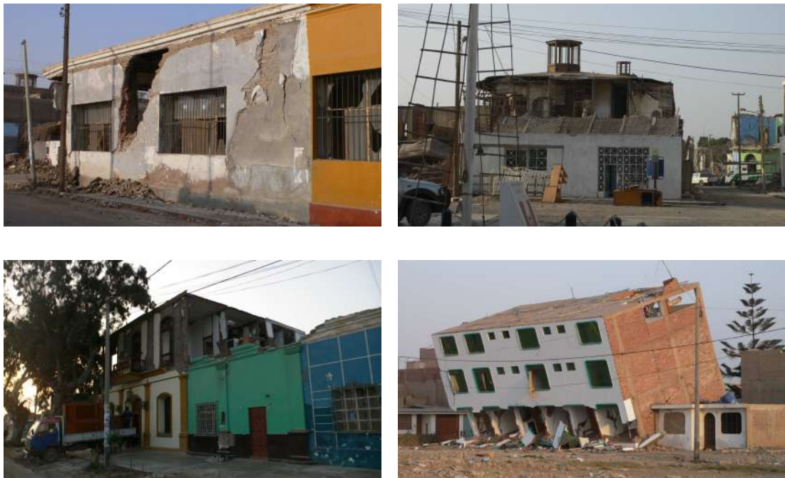
Figura 4.- Diversos tipos de viviendas dañadas en Pisco Playa
