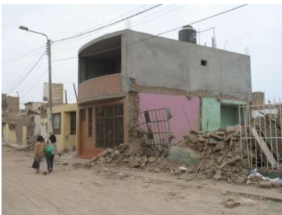
Vivienda Tipo "C" no sufrió daños, las de tipo "A" adobe colapsaron. Pisco
