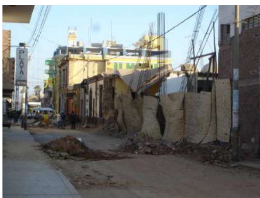
viviendas en la calle Loreto, las de adobe son las que se dañaron más los efectos del sismo.
