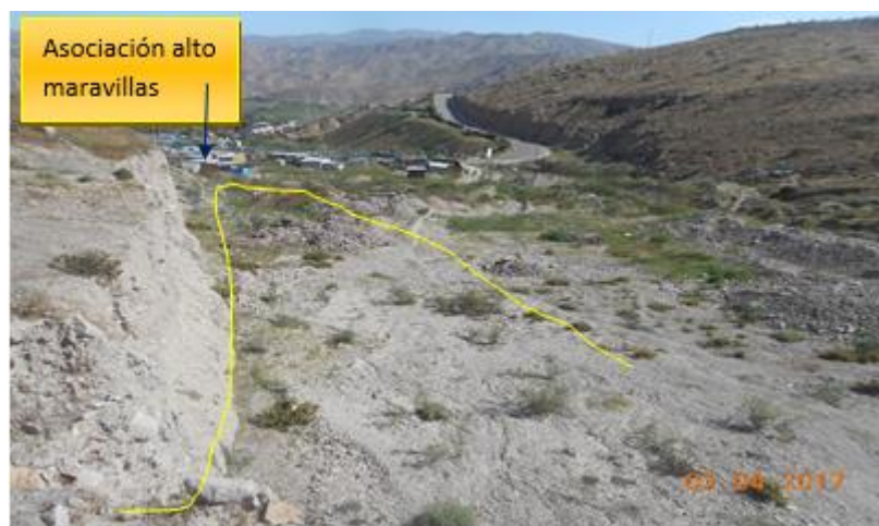
Figura 22: Flujo de detritos (Poligono amarillo), ubicados en las laderas del cerro Baúl.
