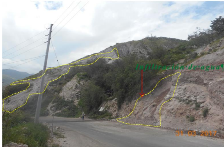
Figura 20: Flujo de detritos (polígonos amarillos) también infiltraciones de agua, (flecha roja). En inmediaciones del Cerro cruz del siglo, al pie de la carretera Binacional a 250 m, al sur este de la Plaza principal.
