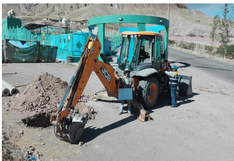
Figura 26: Calicata de 2 m, de profundidad en el sector Centro recreacional en Yacango.
