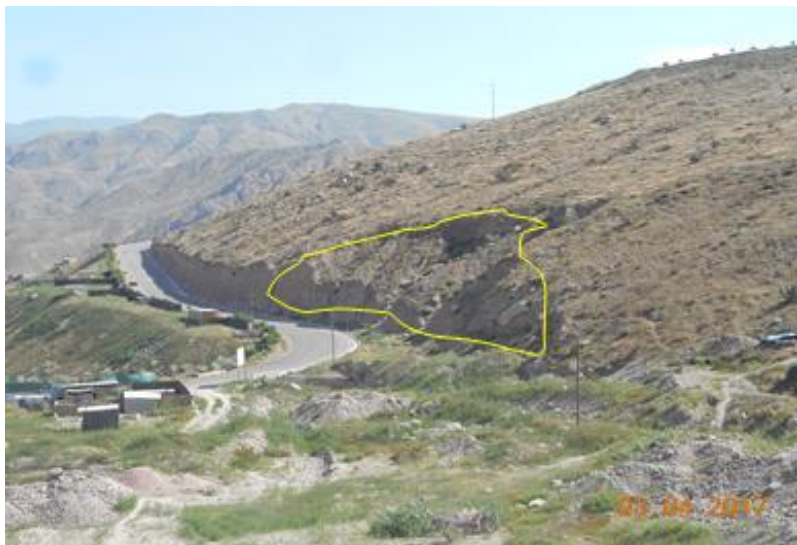
Figura 23: Caída de rocas (polígono amarillo) en el cerro Mejía en el área urbana de Yacango que afecta la carretera Binacional.
