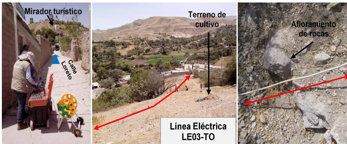
Figura 22: ... Continuación.../ Vista de las líneas eléctricas LE03-TO.
