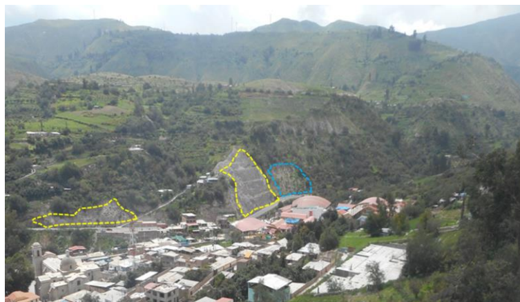
Figura 21: Caída de rocas (polígonos amarillos). En el sector Cerro Blanco, Torata. Al lado deslizamiento ubicado al pie de la carretera binacional (polígono azul).
