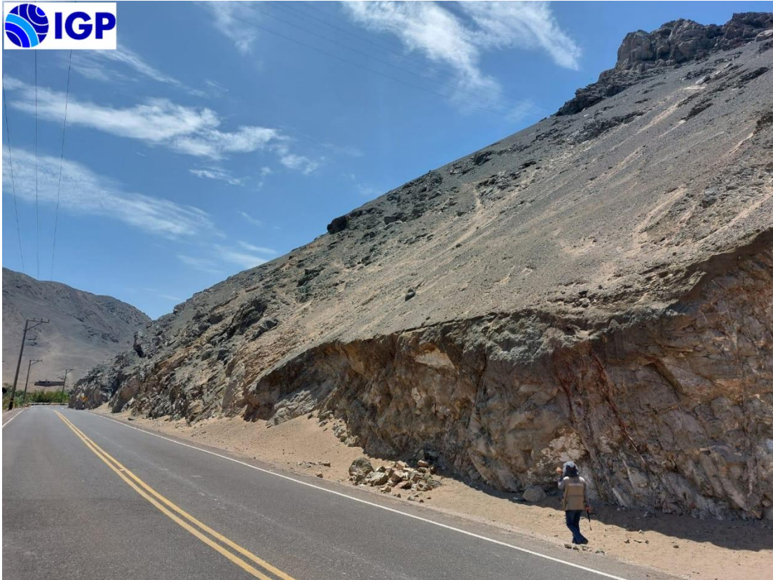
Figura 14: Caída de rocas, por el sector de Poquera.
