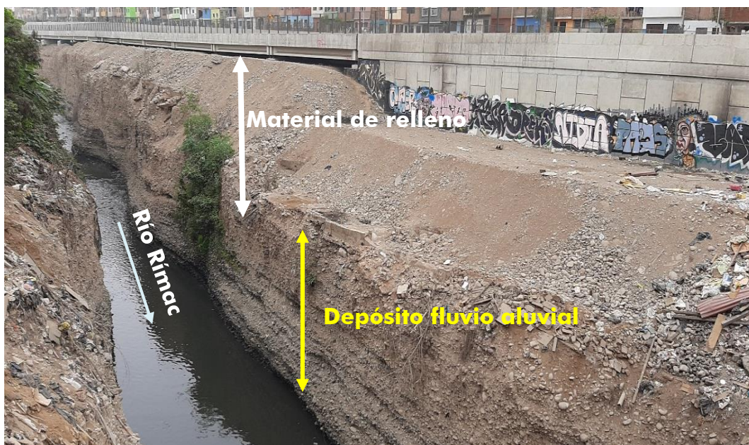
Figura 6. Depósito fluvio aluvial en las márgenes derecha e izquierda del río Rimac. Se observa que está cubierto por materiales antrópicos provenientes del antiguo relleno sanitario de Lima y sobre el cual se asientan las viviendas que conforman AA.HH..
