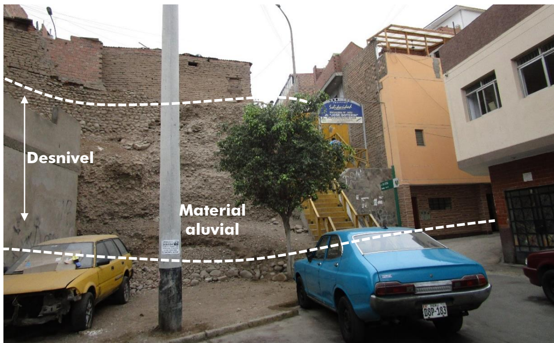
Figura 15. a) Vista del material aluvial que forma la terraza con un desnivel de 4 a 5 metros con la base: AA.HH. Mirones Bajo, próximo a la línea del tren (intersección del Jr. Marino Angulo con el Jr. José Boterín).
