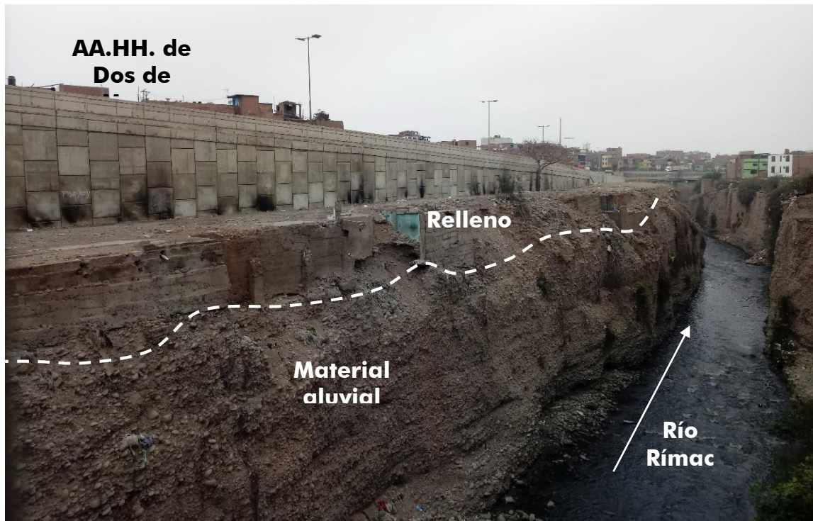
Figura 15. b) Vista de la presencia de material aluvial en la Margen Izquierda del río Rimac cubierto por material de relleno: altura de los AA.HH. 1° de Mayo y Dos de Mayo.
