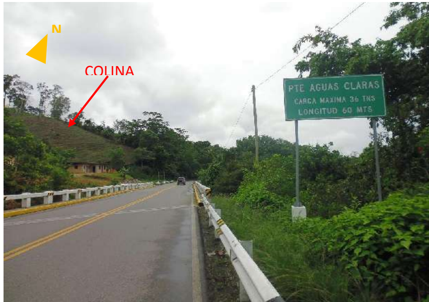
Figura 9. Colina ubicada a 900 m al suroeste del poblado Aguas Claras, margen izquierdo del río del mismo nombre con un desnivel del orden de 100 m.
