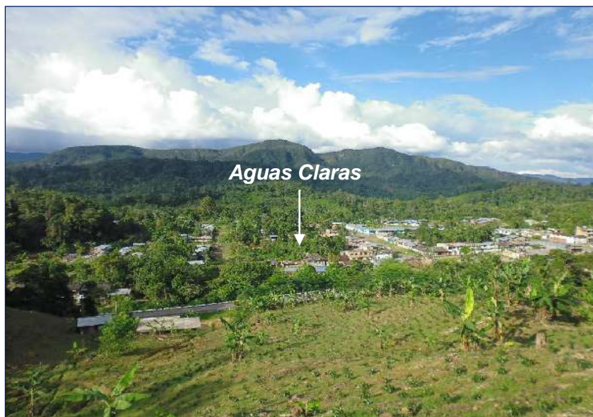
Figura 26: El área urbana del poblado Aguas Claras se asienta sobre depósitos aluviales que suprayacen a las rocas de la Formación Condorsinga.
