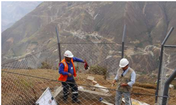
Labor de mantenimiento de estación sísmica.
