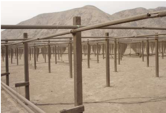
Alineamiento de la antena principal.
