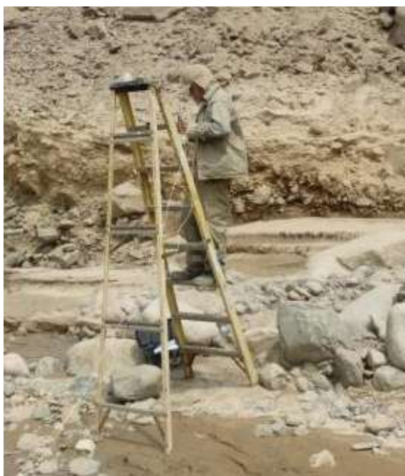
Instalación de crucetas en el cauce del río Huaycoloro.
