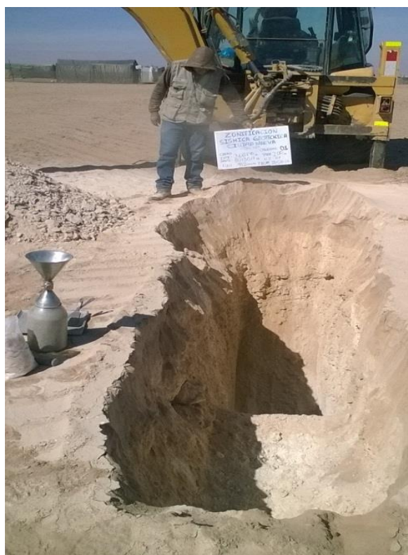
Figura 21: Calicata CN-01 ubicada en el sector de Arquipate.
