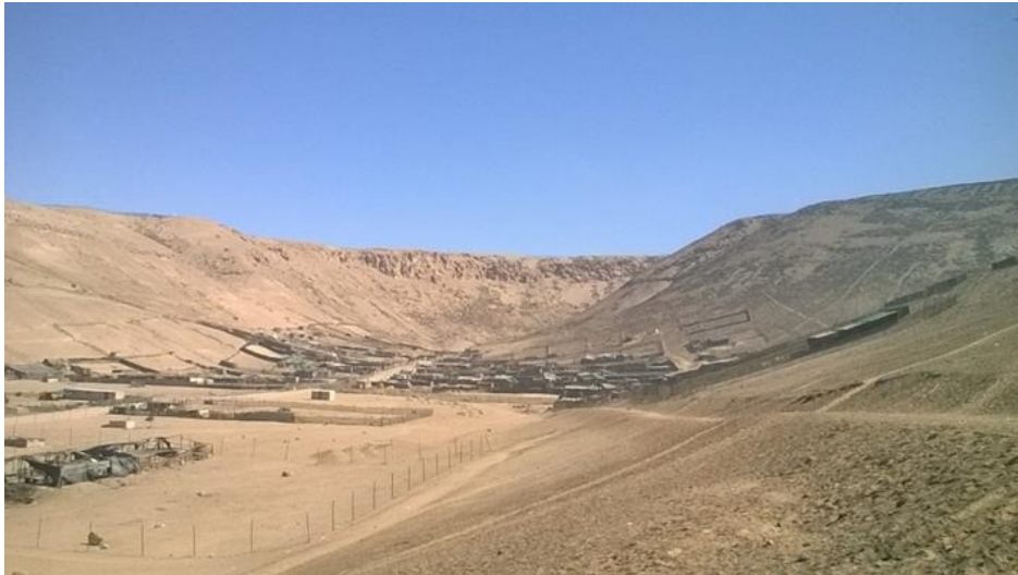
Figura 18: Población situada en el cauce de la quebrada seca, ubicada a 2 km al noreste de Ciudad Nueva, zona potencial de peligro ante una avenida de flujo de detritos acarreado por las escorrentías desde las parte altas.
