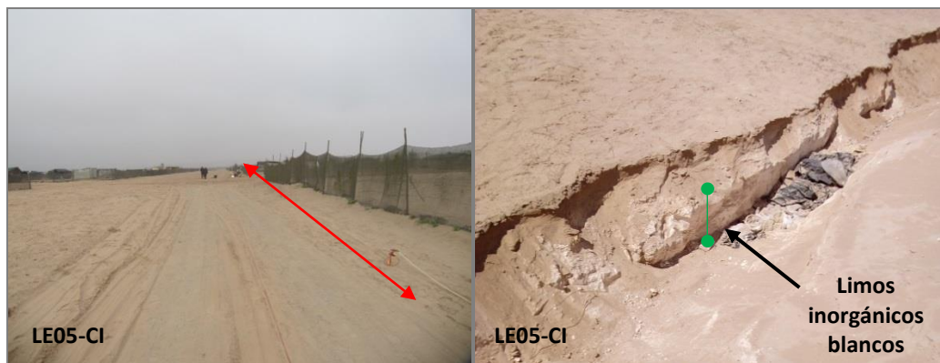
Figura 23: Vista de la línea eléctrica LE05-CI.
