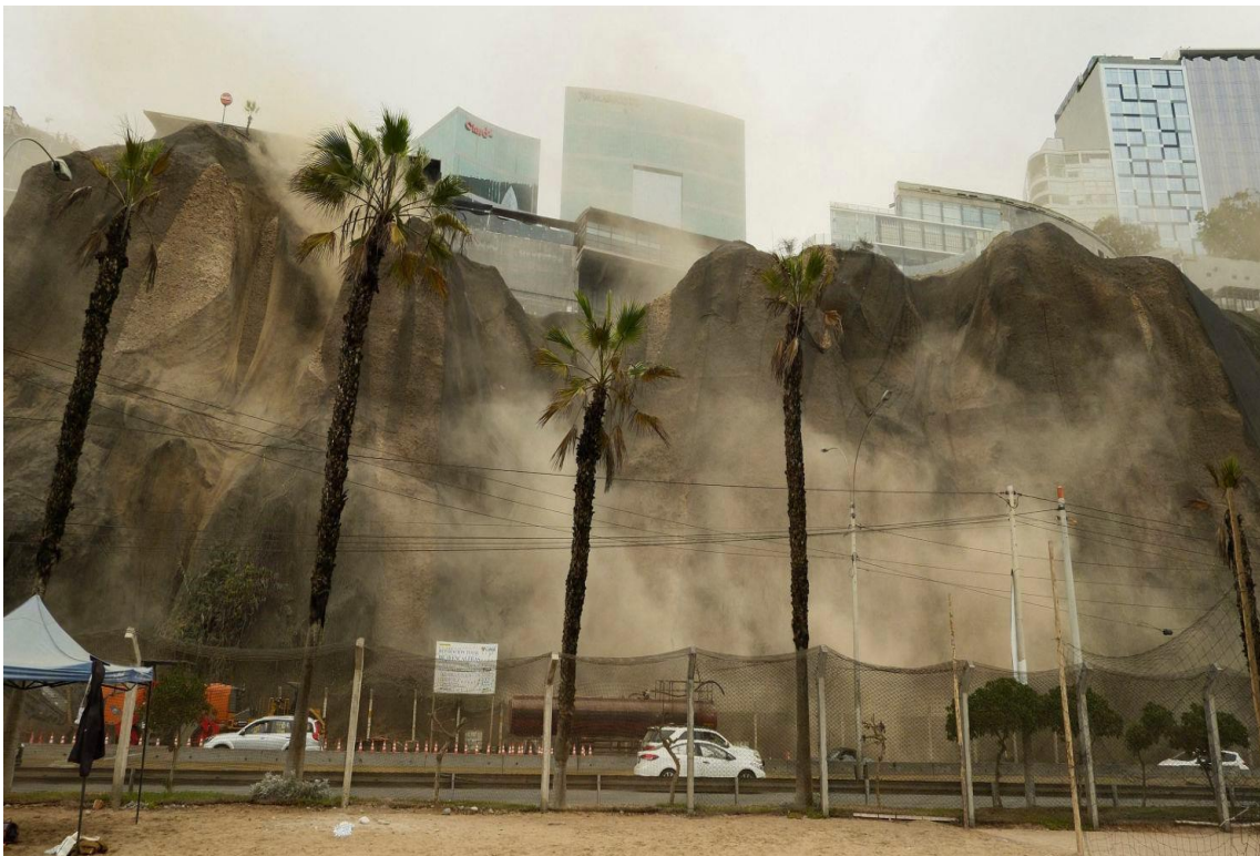
Figura 8a.- Deslizamientos en la Costa Verde producido por el sacudimiento del suelo producto del sismo del 15 de junio 2025 (M6.1). (Fuente: EFE)
