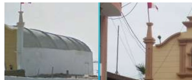
Figura 3.5: Iglesia construida con material noble ubicada en la calle La Manchurria. Posee columnas y vigas de concreto armado y no presenta daños estructurales. Sin embargo, se recomienda que la evacuación de las personas sean direccionadas con más señalización y simulacros.
