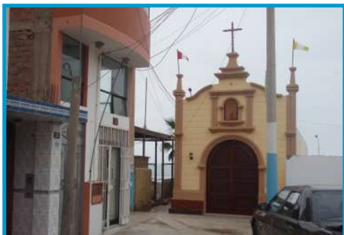
Figura 3.5: Iglesia construida con material noble ubicada en la calle La Manchurria. Posee columnas y vigas de concreto armado y no presenta daños estructurales. Sin embargo, se recomienda que la evacuación de las personas sean direccionadas con más señalización y simulacros.
