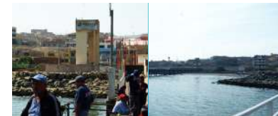
Figura 3.9 Edificación donde se ubica el terminal pesquero de FONDEPES con más de 10 años de antigüedad, situada sobre la playa de Huacho. En la vista se observa el enrocado realizado para evitar el socavamiento de las bases de la plataforma de maniobra de este puerto.
