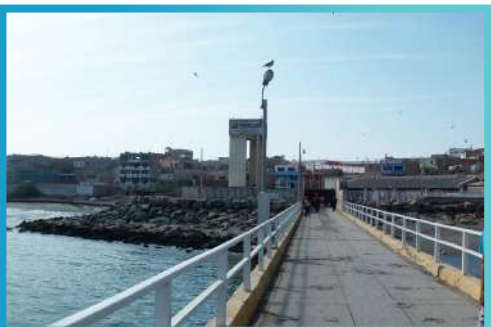
Figura 3.9 Edificación donde se ubica el terminal pesquero de FONDEPES con más de 10 años de antigüedad, situada sobre la playa de Huacho. En la vista se observa el enrocado realizado para evitar el socavamiento de las bases de la plataforma de maniobra de este puerto.
