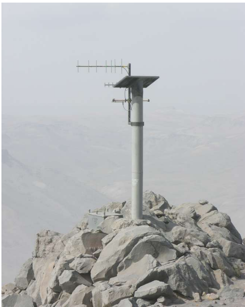
Estación de monitoreo de la actividad del volcán Ubinas, en Moquegua.
