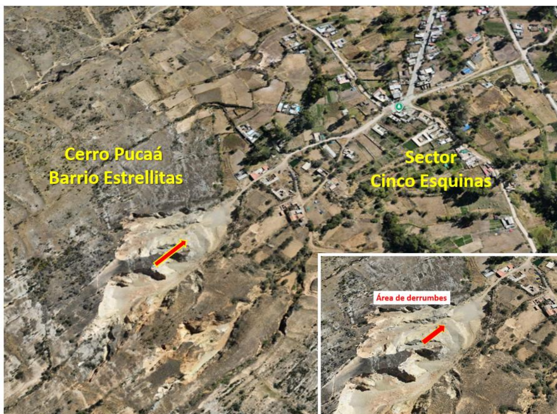
Figura 8.- Ubicación geográfica del Cerro Pucaá en Barrio Estrellita y ruta de acceso desde el Sector Cinco Esquinas. La flecha de color rojo indica la ubicación del área de suelos inestables y la dirección que siguen los derrumbes, y flujos en temporadas de lluvias.
