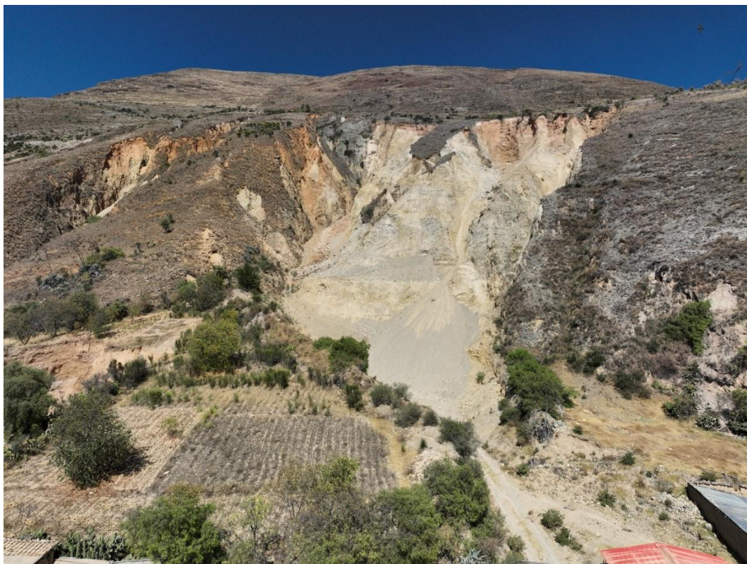
Figura 5.- Vista panorámica de las zonas de derrumbes hacia terrenos agrícolas y viviendas.
