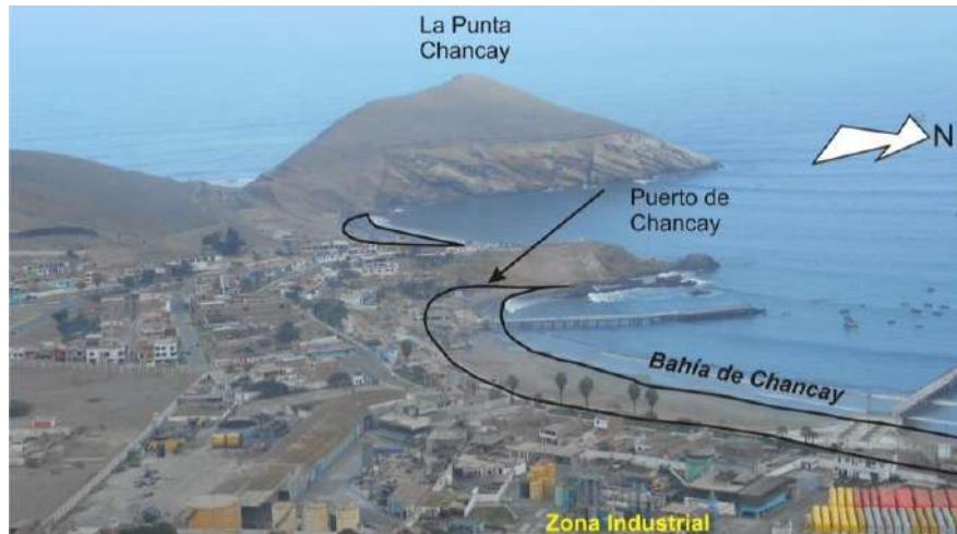
Figura 34: La Bahía de Chancay se extiende aproximadamente sobre una longitud de 1000m, para luego ser interrumpida por un afloramiento volcánico sedimentario
