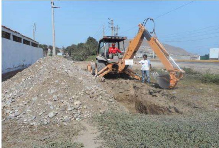
Figura 7: Calicata elaborada en Chancay con el apoyo de la municipalidad. Extracción de muestras para conocer, por ejemplo, la densidad del suelo mediante el método del Cono de Arena.
