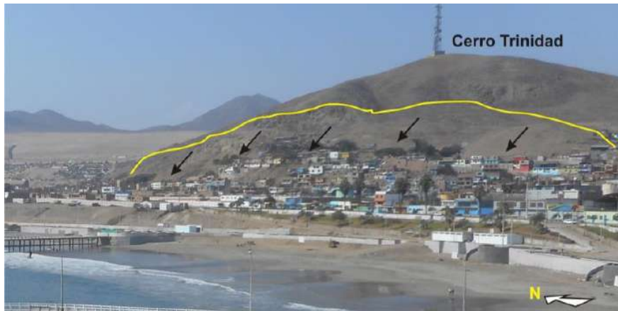
Figura 5a: Lado oeste del cerro Trinidad en el sector Túpac Amaru, afectado por procesos geodinámicos: caída de rocas
