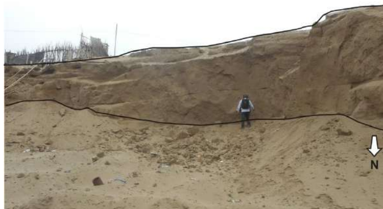
Figura 44: En el sector norte de 28 de Julio, los bancos de arena están siendo ocupados por los pobladores para construcción de viviendas
