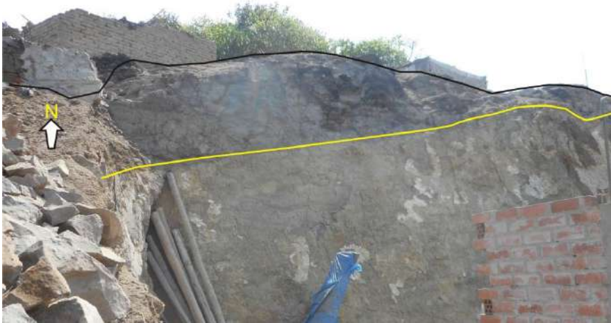
Figura 40: En un corte de talud se aprecian calizas margosas en contacto con tonalitas oscuras bien compactas
