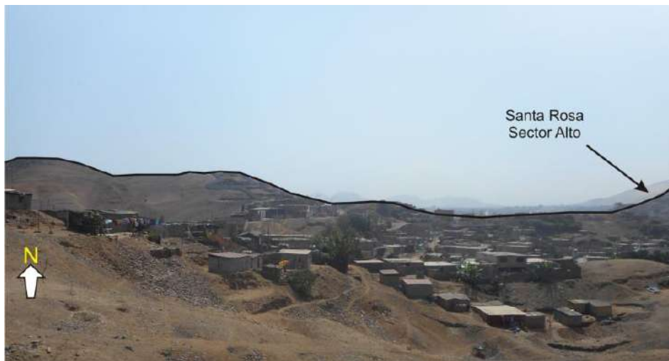
Figura 28: Viviendas en el sector de Santa Rosa asentadas sobre lomas que se encuentran cubiertas por clastos y bloques sobre un basamento intensamente fracturado.
