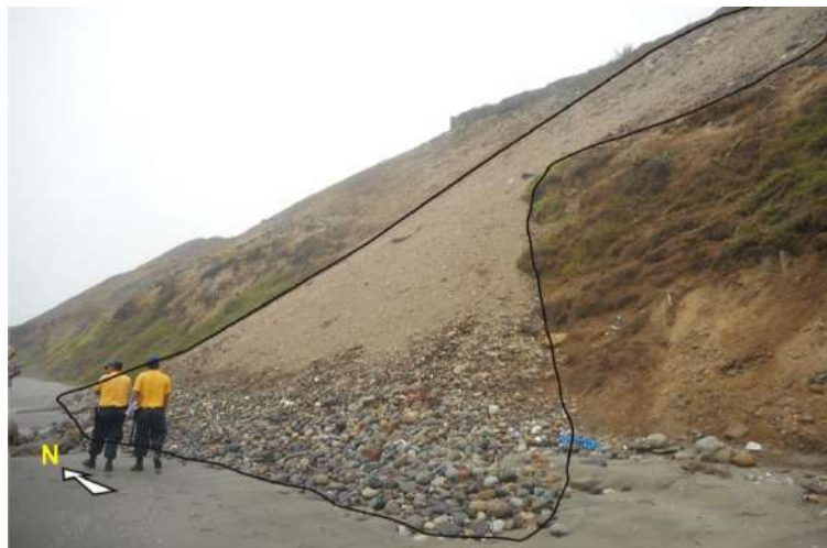
Figura 48. Los materiales conformados principalmente por gravas se han desprendido debido al factor antrópico, construcción de viviendas en el borde del acantilado
