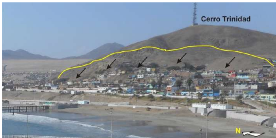
Figura 53: El lado oeste del cerro Trinidad, sector Túpac Amaru, es afectado por caída de rocas
