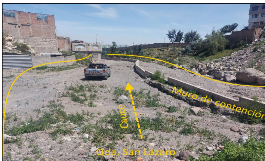
Figura 12. Viviendas construidas en el cauce de la quebrada San Lázaro (P. J. Alfonso Ugarte).
