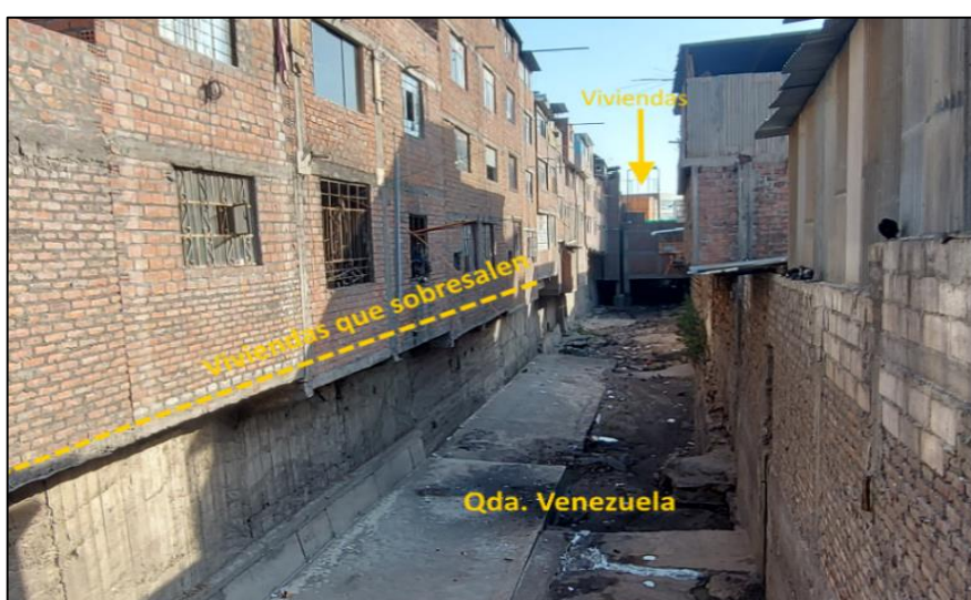
Figura 13. Viviendas construidas en el cauce de la quebrada San Lázaro (P. J. Alfonso Ugarte).
