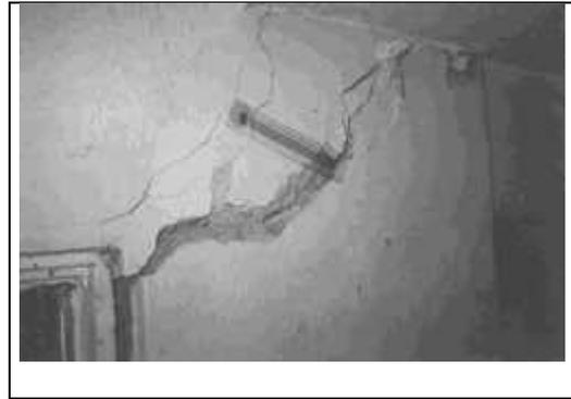
**Figura 2.** control de grietas en los muros de viviendas de la urbanización San Luis
