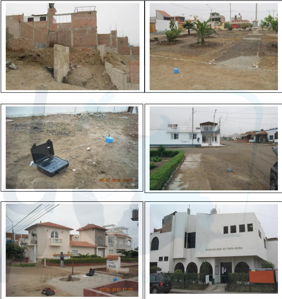
Figura 7.- Vistas del tipo de suelo y viviendas en el Distrito de Punta Negra. En las fotos superiores se observan viviendas edificadas sobre suelos arenosos y, en algunos casos, sobre zonas de rellenos compuestos de ladrillos y fragmentos de rocas. En este Distrito predominan edificaciones de uno y dos niveles.
