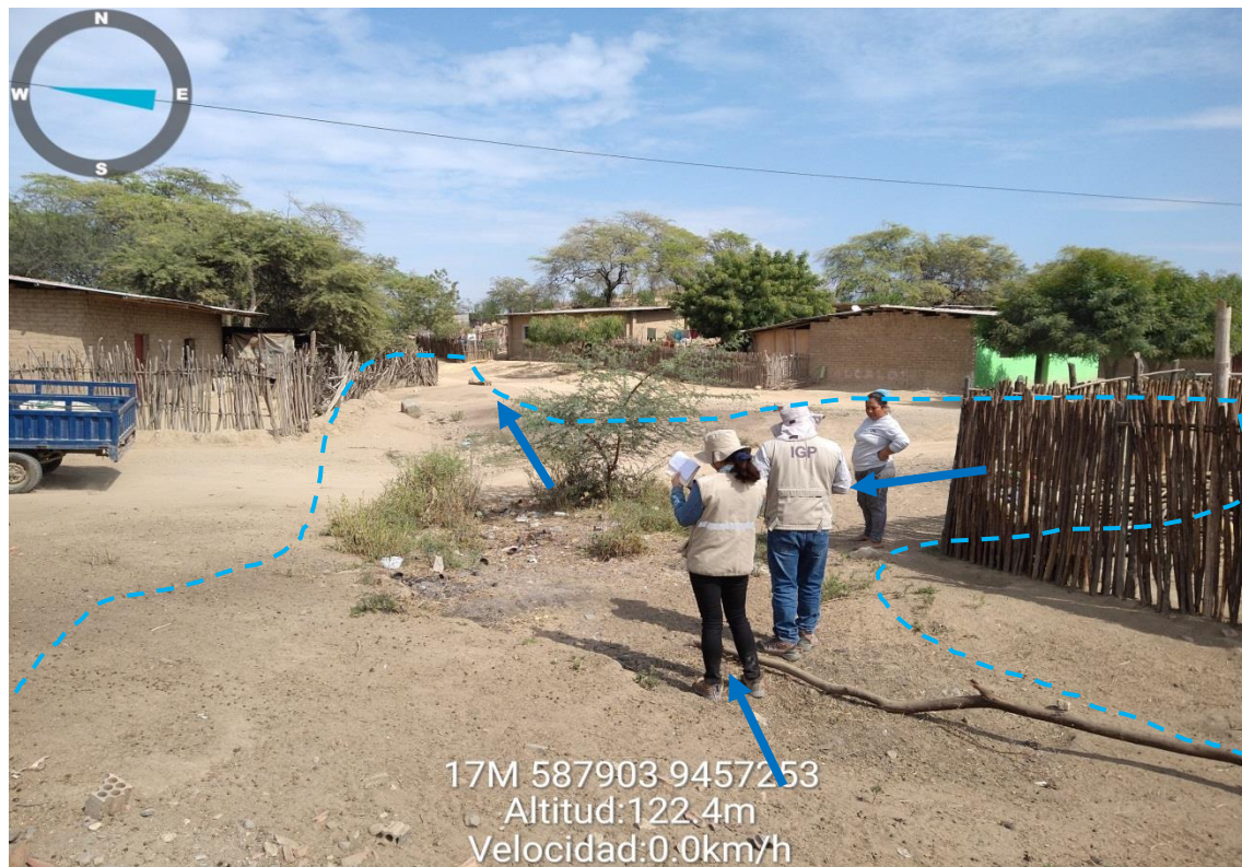
Figura 15.- Áreas afectadas (polígono celeste) por inundaciones pluviales debido a la evacuación de las aguas pluviales hacia la calle que podría afectar la vía y viviendas contiguas
