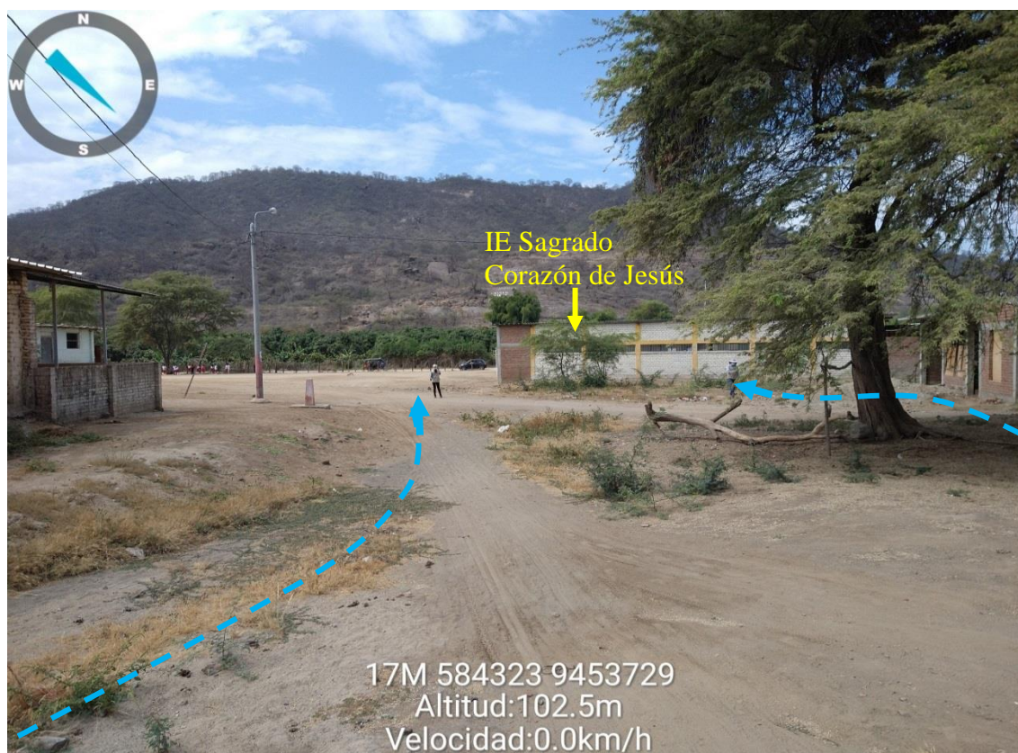
Figura 19.- Canales que drenan en dirección a la IE Sagrado Corazón de Jesús, afectando directamente dicha institución, así mismo sus aguas discurren hacia la avenida principal del caserío
