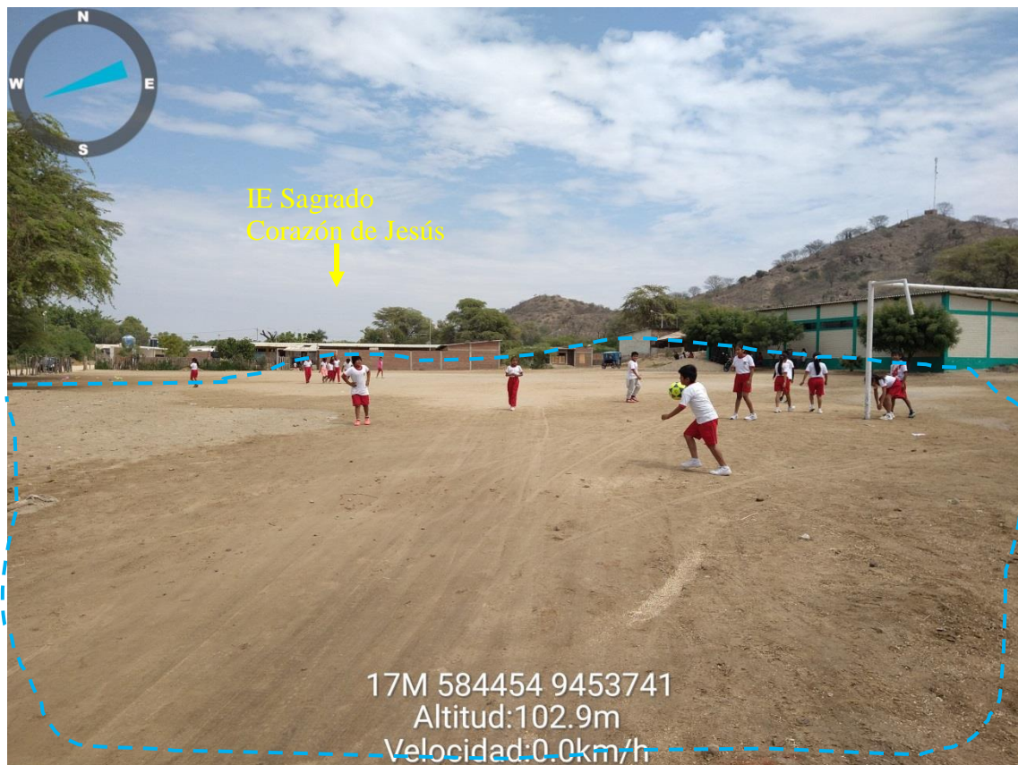
Figura 21.- La cancha deportiva que se encuentra aledaña a la IE Sagrado Corazón de Jesús, también es afectado por la acumulación pluvial, debido a la falta de drenaje
