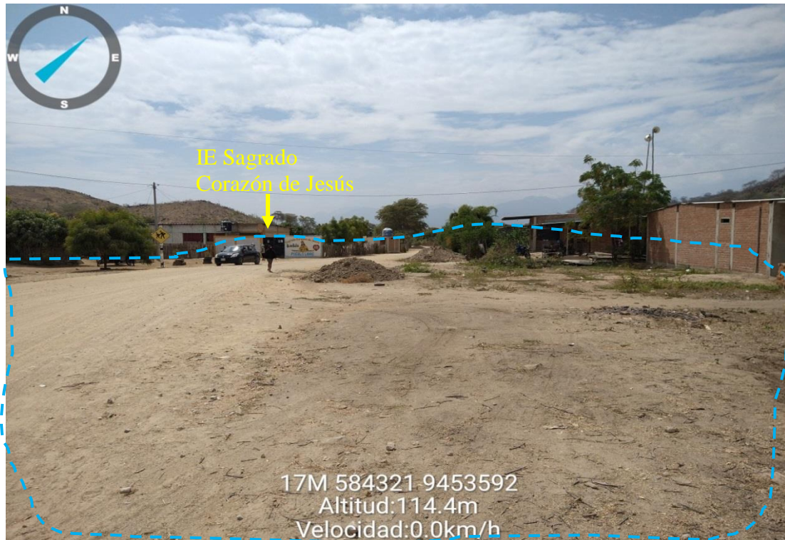
Figura 20.- Zona de acumulación de aguas pluviales (contorno celeste) que afecta la avenida principal del caserío Pueblo Libre, así mismo las viviendas que se encuentran aledañas
