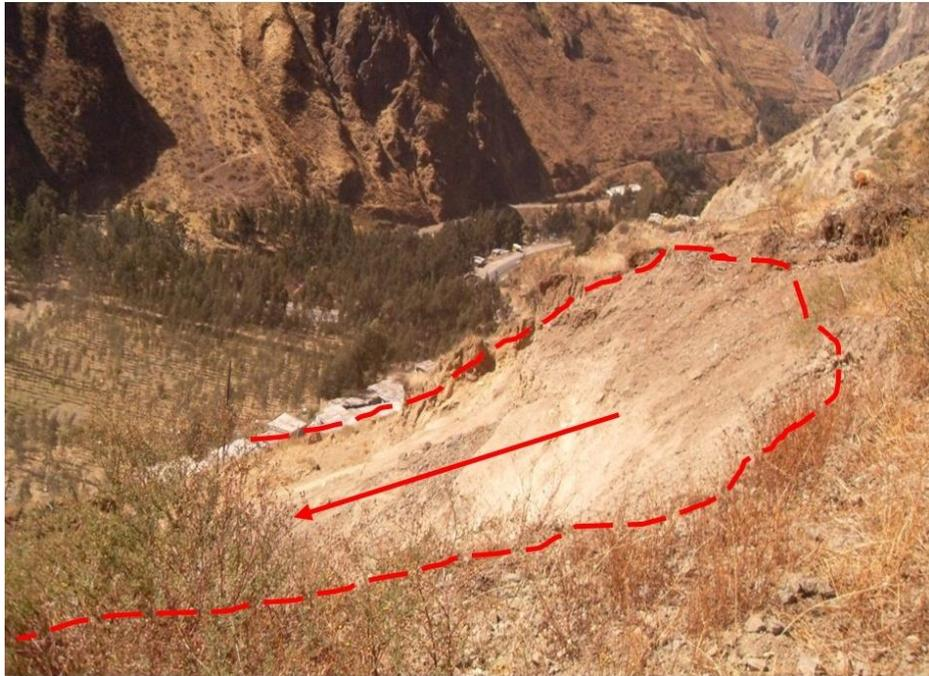
Figura 16 Vista desde la parte alta del deslizamiento (D-1) producido el 16 de agosto del 2011, que afecta desde el talud hasta la Carretera Central.
