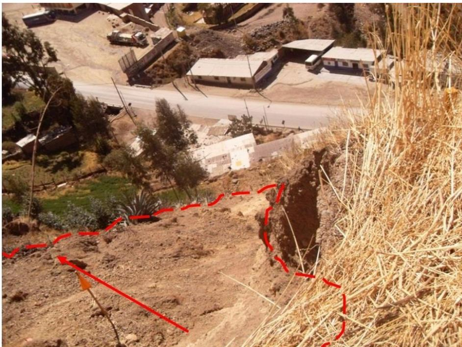
Figura 17 Vista del deslizamiento (D-2) ubicado en el extremo norte de la Quebrada Chahuatupe, donde se asientan viviendas contiguas a la Carretera Central.
