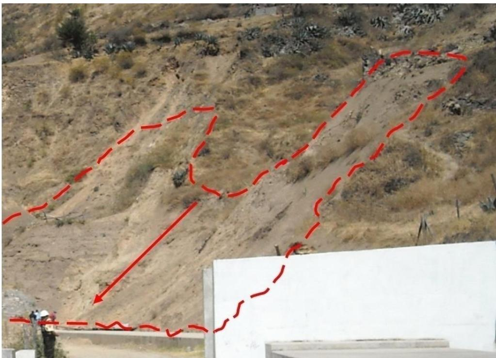
Figura 21 Deslizamiento (D-4) ocurrido en el extremo Norte del canal de aducción; lugar donde hicieron trabajos para la estabilización de la ladera.
