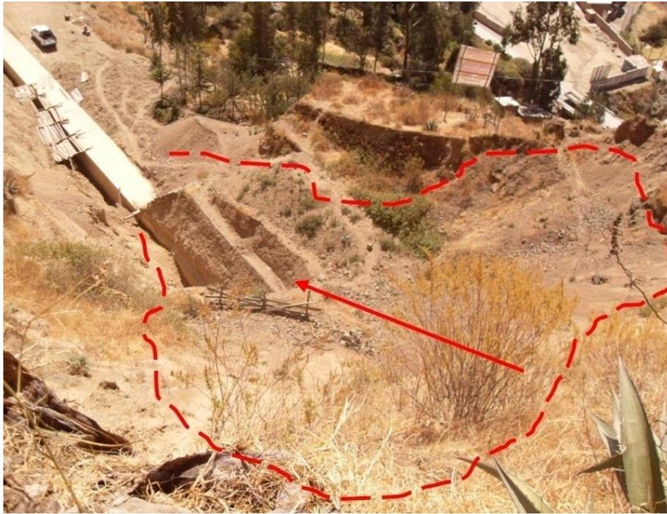
Figura 20 Deslizamiento (D-3) que afecta al canal de aducción, ubicado en la parte alta de la portada del túnel.
