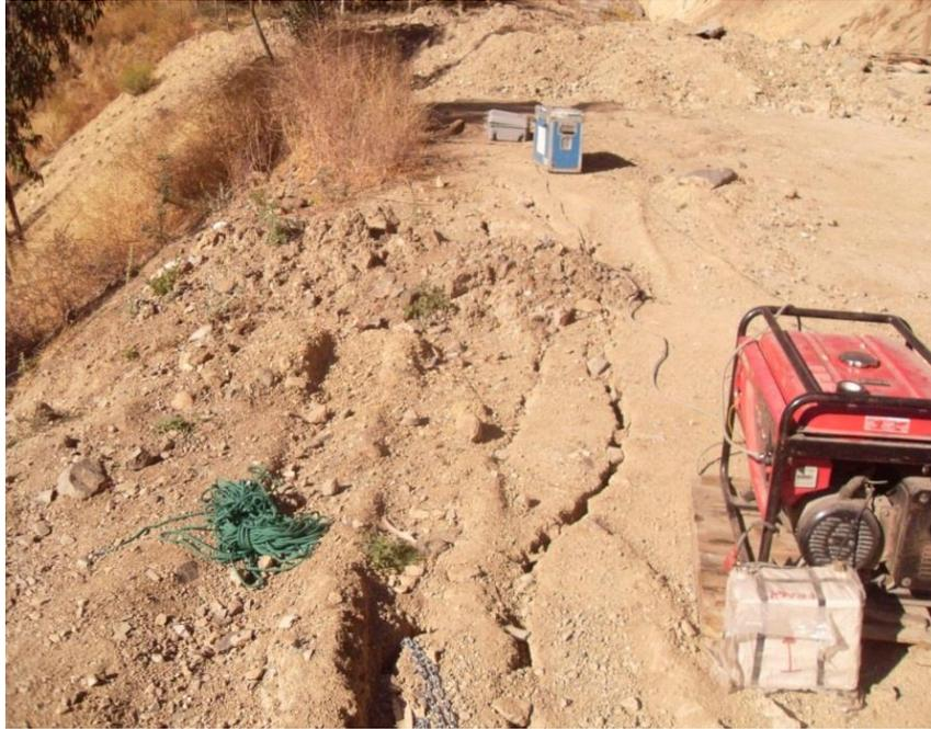
Figura 14 Agrietamientos paralelos a la orientación del canal de aducción que afectan al suelo areno limoso, sector el badén en la cota 3145 m.s.n.m.
