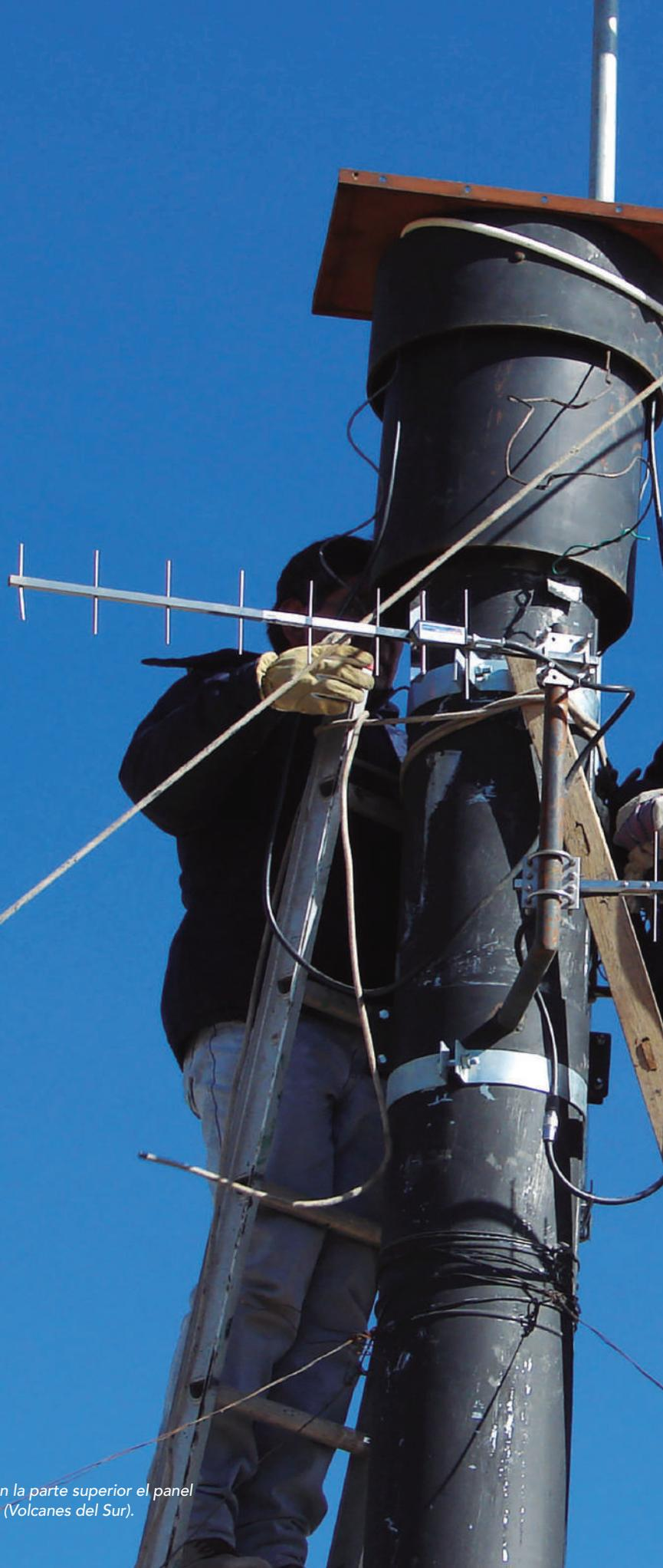
*Mantenimiento del sistema de energía fotovoltaico y del sistema de comunicación, se aprecia en la parte superior el panel solar y un par de antenas Yagui, las cuales están conectadas a un sistema de radio tranceptores (Volcanes del Sur).*
