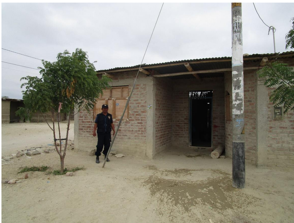
Figura 15: El agua a 40 cm de altura, afectó a las viviendas localizadas en el sector Tablazo Norte.
