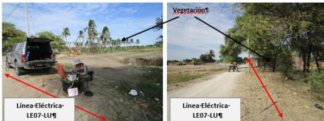
Figura 17. Vista de la línea eléctrica LE07-LU.
