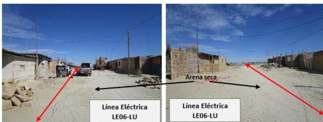
Figura 16: Vista de la línea eléctrica LE06-LU.
