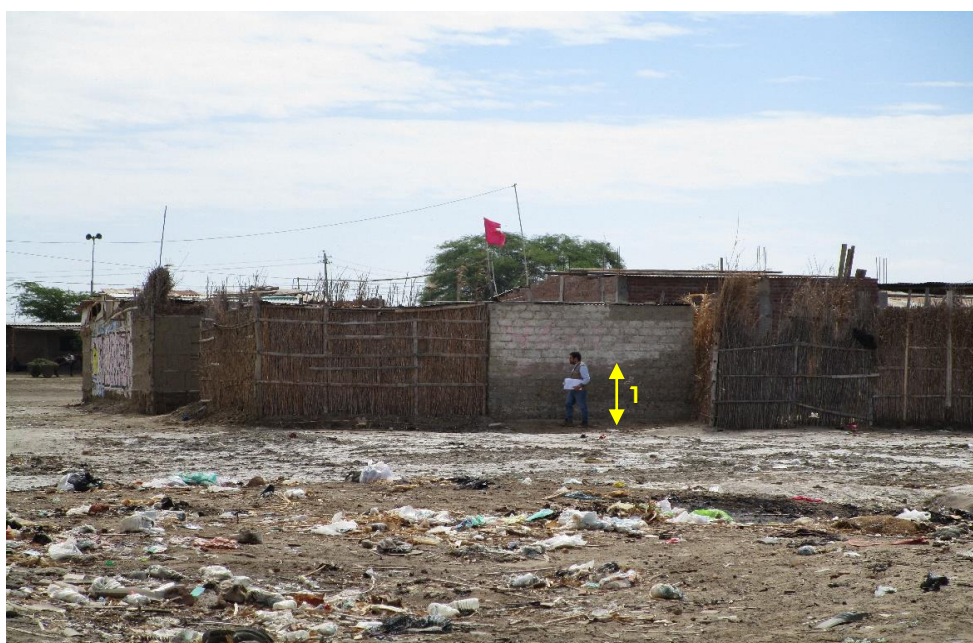
Figura 14: El agua a 1 m de altura, afectó a las viviendas localizadas en el sector Arroyo Mío.
