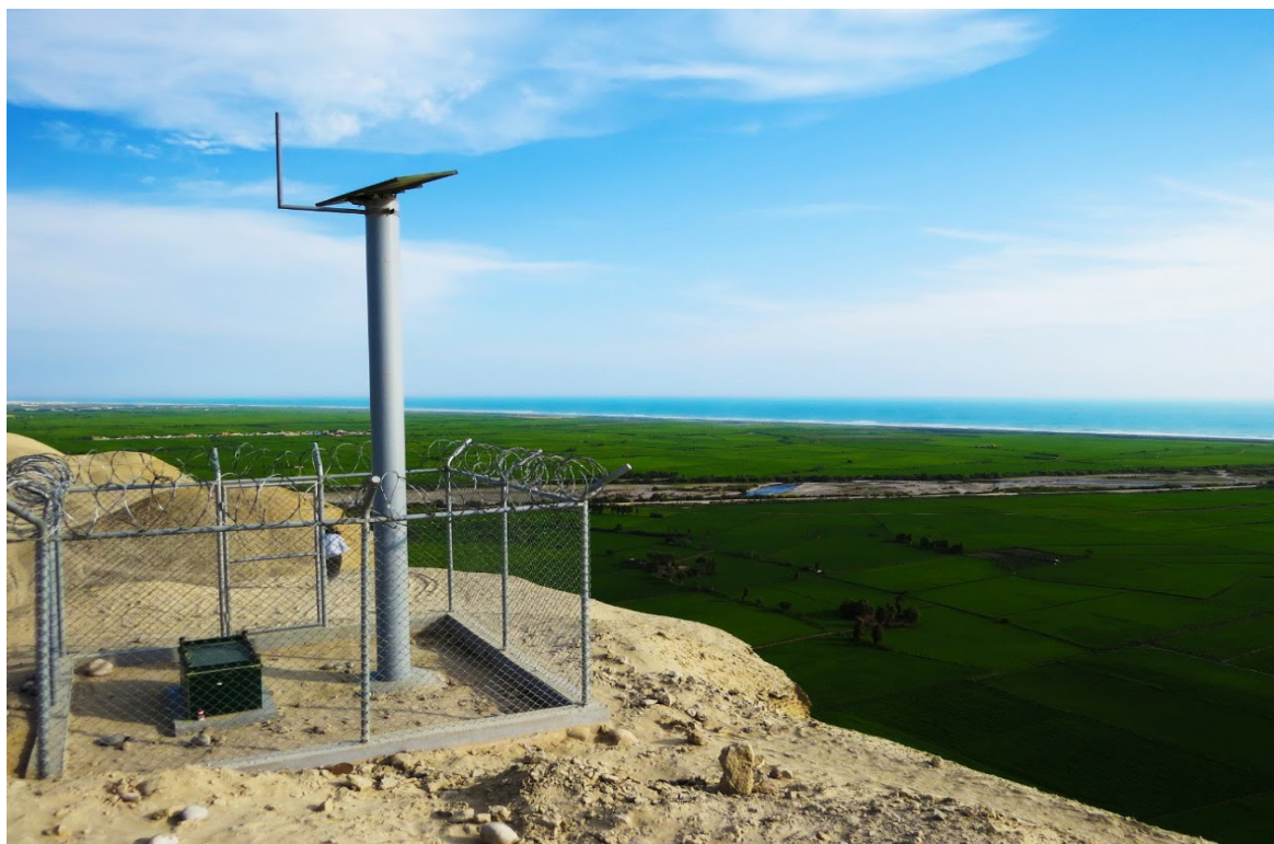
Estación de vigilancia de SASPe
