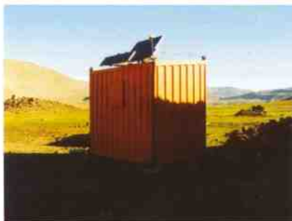
Figura 2. Habitación donde se instalaron los equipos de EA y los paneles solares.
