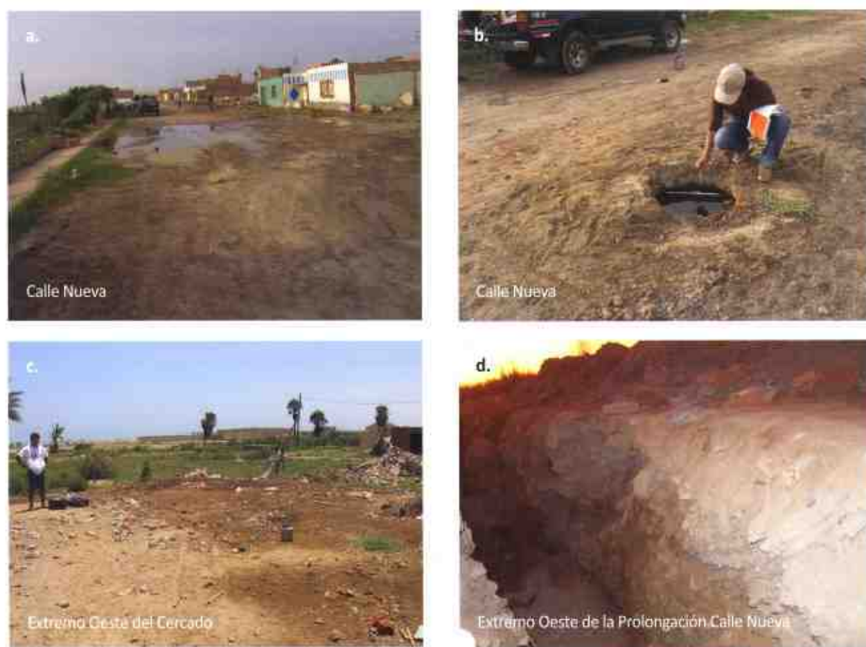
Figura 2. Fotos representantes del AREA1. a) y b) En algunas zonas existen afloramientos del nivel freático. c) Zonas de relleno y d) Se muestra una zanja de medio metro de profundidad. Nótese la presencia de humedad.
