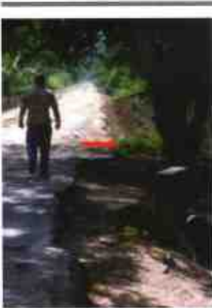
Figura 8. Desplazamiento cosísmico generado por la falla de El Pilar a nivel de la carpeta asfáltica de una carretera, en el terremoto de 1997. Fuente: Audemard (1997).
