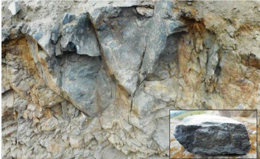
Figura 31: Las andesitas se encuentran intensamente diaclasadas, además de presentar coloraciones oscuras y oxidaciones producto de la humedad de la zona
