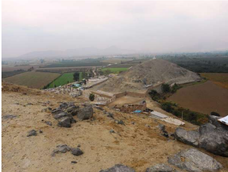
Figura 5a: Sector Huando en la ciudad de Huaral. Obsérvese la presencia de materiales detríticos que por procesos geodinámicos se deslizan hacia las viviendas.
