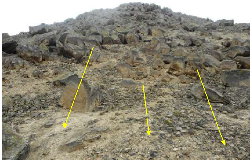
Figura 40: En el cerro Huando, se observa pendientes superiores a 39^\circ y los materiales que se desprenden se depositan en la parte baja, cerca de las viviendas.
