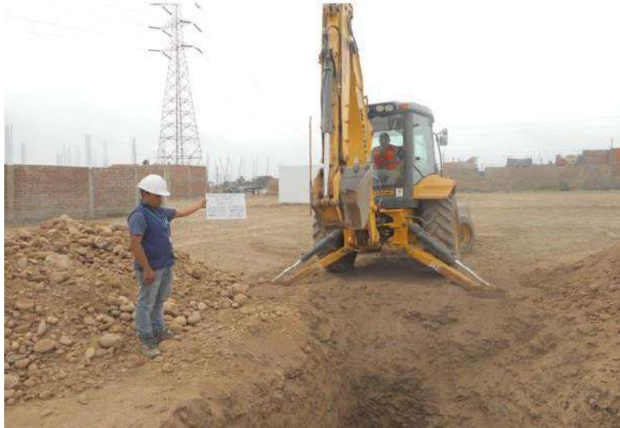
Figura 6: Calicata elaborada en Huaral con el apoyo de la municipalidad. Extracción de muestras para conocer, por ejemplo, la densidad del suelo mediante el método del cono de arena.
