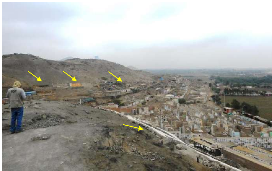
Figura 41: Las viviendas distribuidas en las laderas de los cerros son susceptibles a la cada de rocas
