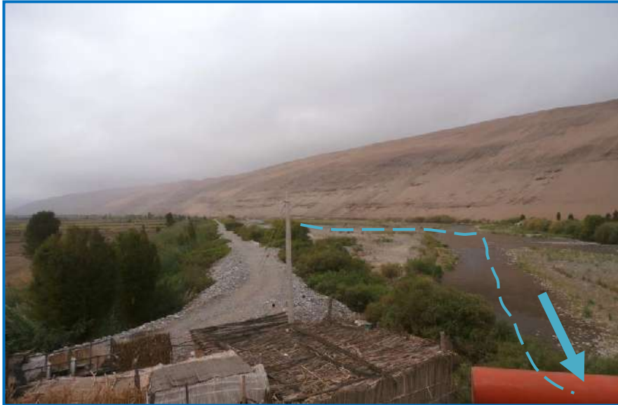
Figura 47: En la margen derecha del río no existe revestimientos, por lo tanto, el desborde del río afectaría a viviendas y campos de sembrío.
