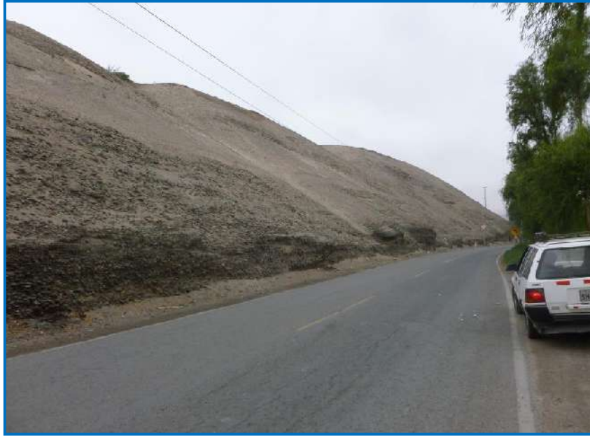
Figura 41: AAHH El Canto y corte de talud en el cual se observa la secuencia estratigráfica de los depósitos aluviales.
