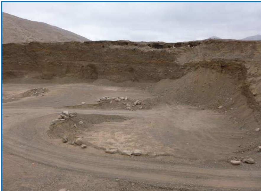
Figura 43: Corte de talud ubicado a 700 metros en dirección NE de la ciudad de Cochachaca. Obsérvese los desniveles en la superficie producidos por la extracción de materiales para construcción.
