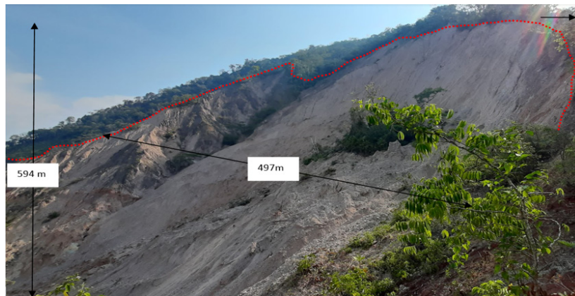
Figura 32. Dimensiones actuales del deslizamiento suscitado en el paraje Tabernuy, con un escarpe que supera los 550 m de longitud.
