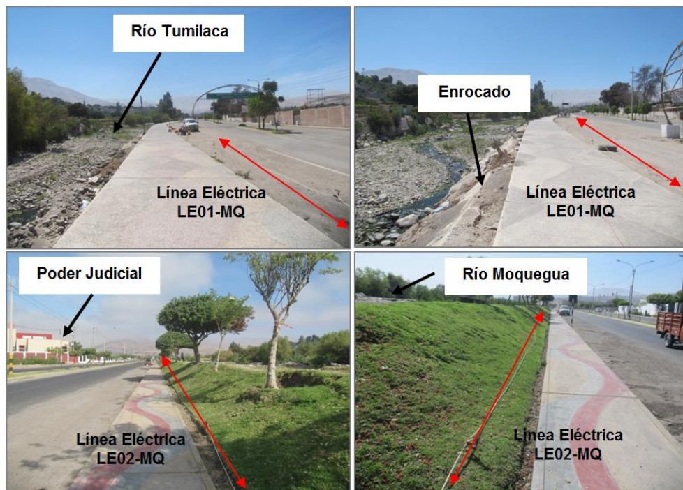
Figura 22. Vista de las líneas eléctricas LE01-MQ y LE02-MQ.
