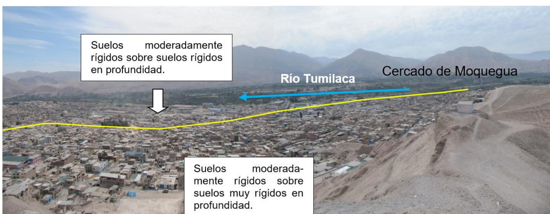
Figura 20: Suelos rígidos y muy rígidos que se extienden en profundidad, emplazados por debajo de suelos moderadamente rígidos (Vista del Cercado de Moquegua desde el Mirador)
