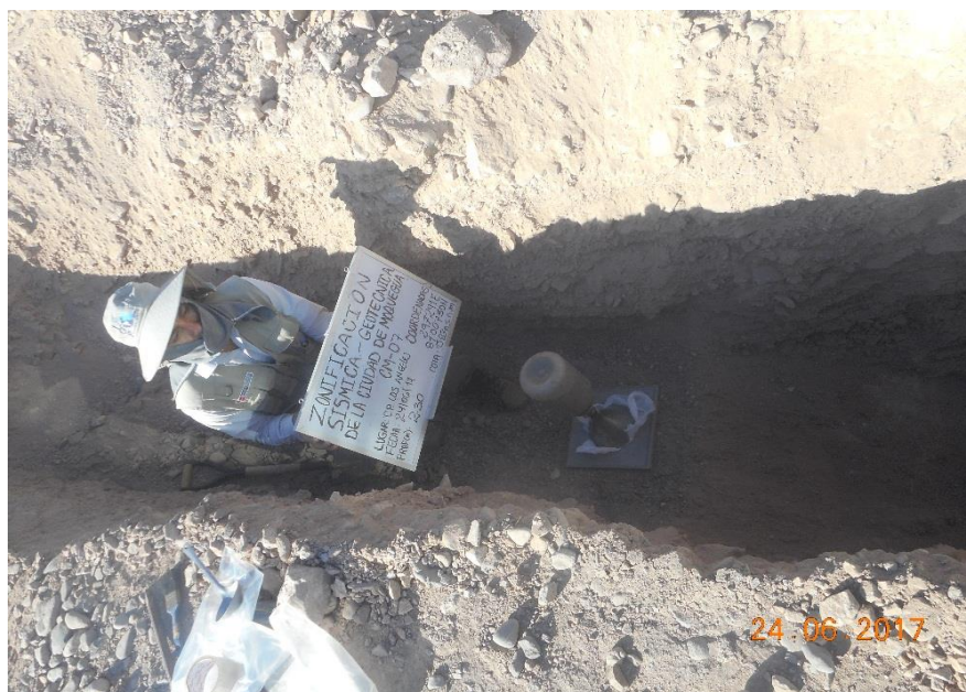
Figura 32: Ensayo de densidad del suelo in-situ en la calicata CM-0 7.
