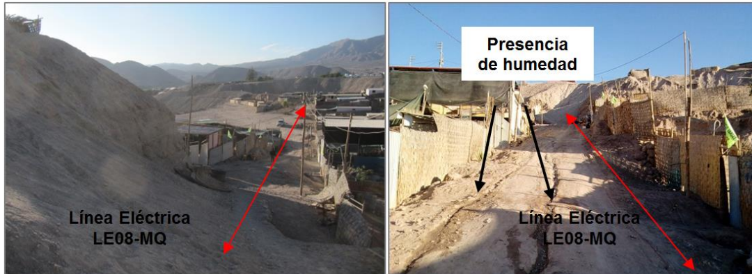
Figura 26: Vista de las líneas eléctricas LE08-MQ.
