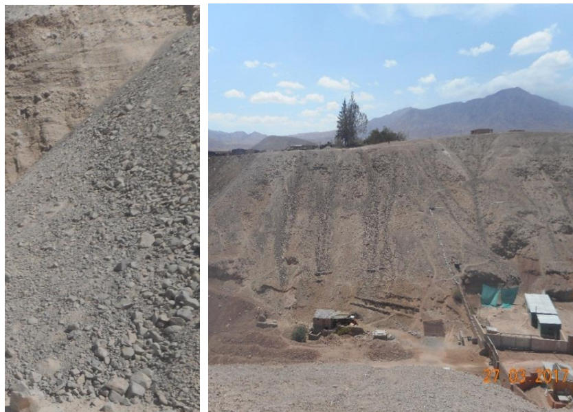
Figura 24: Caída de Rocas a Inmediaciones de A.H. El Siglo-San Antonio y Parte baja de San Francisco.
