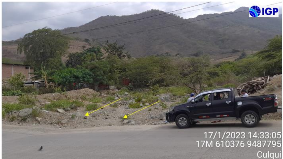
Figura 29.- Cauce de la quebrada Culqui (flechas amarillas) susceptible a la ocurrencia de flujos de detritos ante el incremento de las precipitaciones pluviales que podría afectar el badén de la vía Paimas – Culqui
