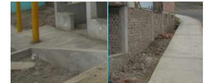
Figura 3.9: Casa de material noble ubicada en la zona de Puerto Chico construida hace aproximadamente 5 años. La vivienda se encuentra en la parte baja de una ladera y presenta elementos vulnerables, tales como fierros corroídos y muros sin soporte estructural adecuado.
