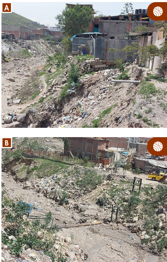
Figura 21. Fotografías de las zonas urbanas expuestas al peligro por descenso de lahares en la quebrada Huarangal. A) Núcleo urbano Miguel Grau, Zona A. B) Núcleo urbano 29 de Agosto.
