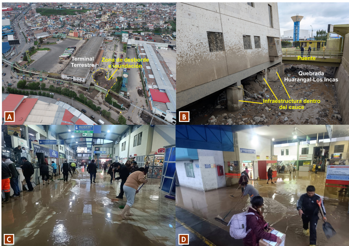
Figura 27. A) Vista del Terminal Terrestre, donde la quebrada Huarangal-Los Incas se desbordó y generó serios daños. B) Vista del cimiento del Terminal Terrestre construido sobre el cauce de la quebrada Huarangal-Los Incas. En este sector, dicha quebrada tiene 4 m de ancho. C y D) Efectos del desborde e inundación en el interior del Terminal Terrestre.
