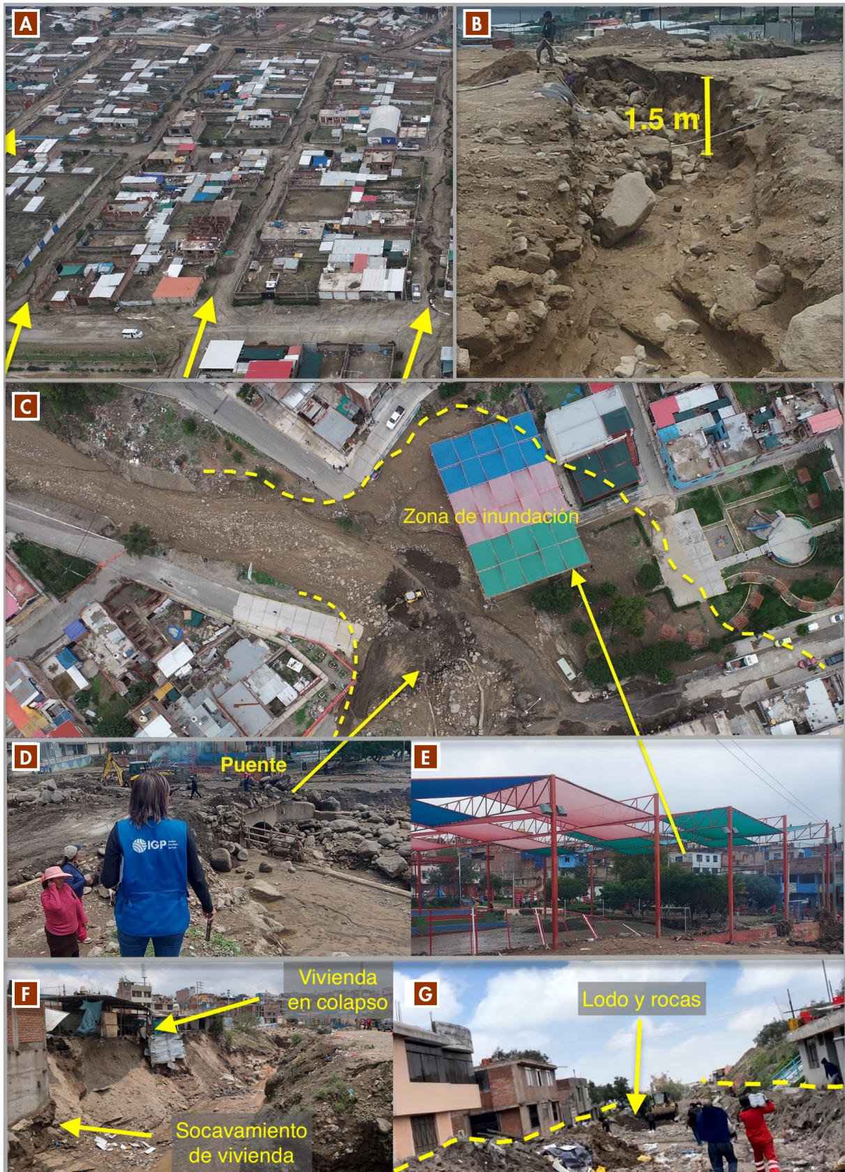
Figura 20. A y B) Asociación de vivienda Cabrerías, afectada por las intensas lluvias que provocaron surcos debido a la erosión del suelo constituido de material volcánico. C y D) Zona de Villa Continental: puente sobre la quebrada Azufral afectado y sobrepasado por un lahar con bloques de más de 1.5 m de diámetro. E) Losa deportiva de Villa continental inundada, con cerco derribado por lahares. F) Colapso de viviendas en Villa Continental. G) Afectación por lahar en Juan Pablo II.
