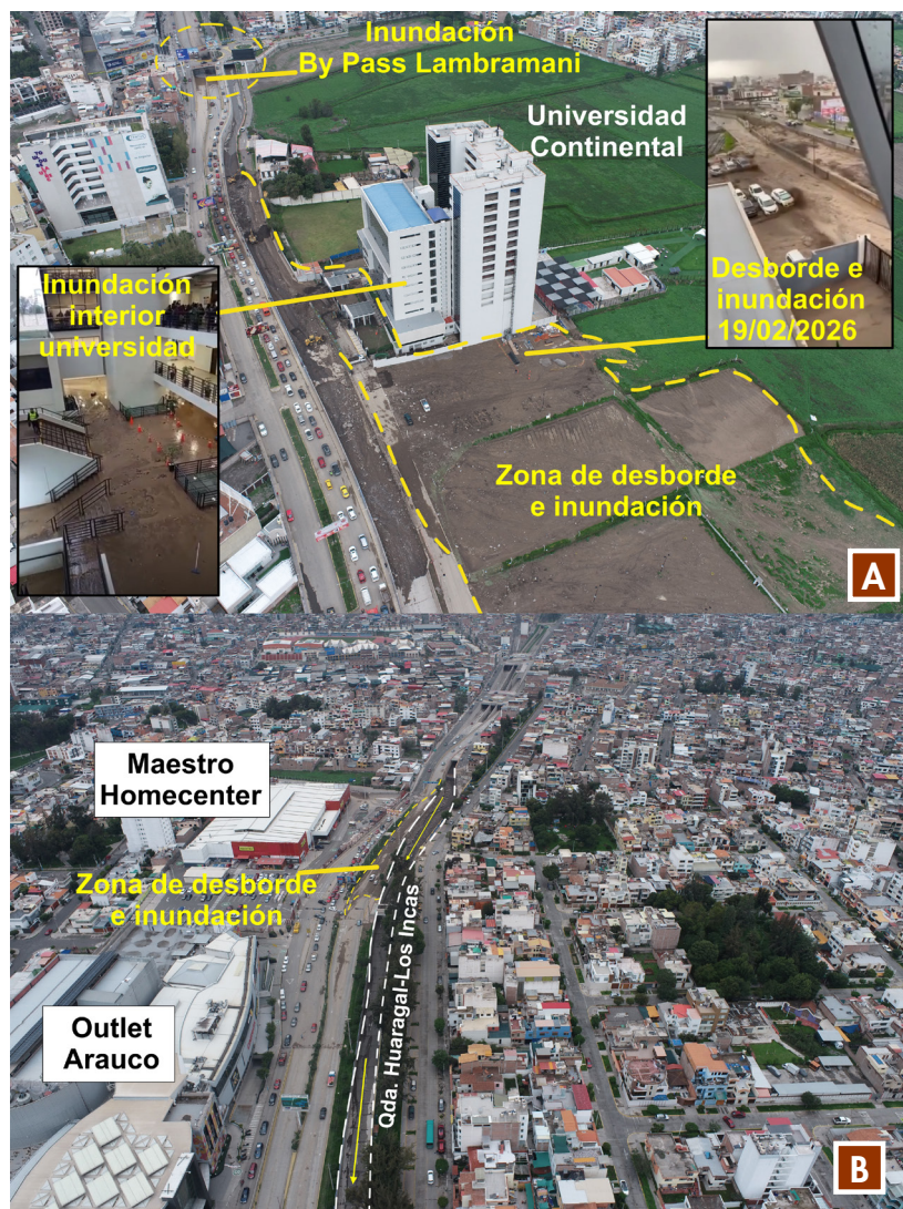
Figura 22. Vista del curso medio de la quebrada Huarangal-Los Incas en inmediaciones del centro de la ciudad de Arequipa. A) Desborde e inundación en la Universidad Continental. B) Desborde e inundación en la avenida Los Incas.
