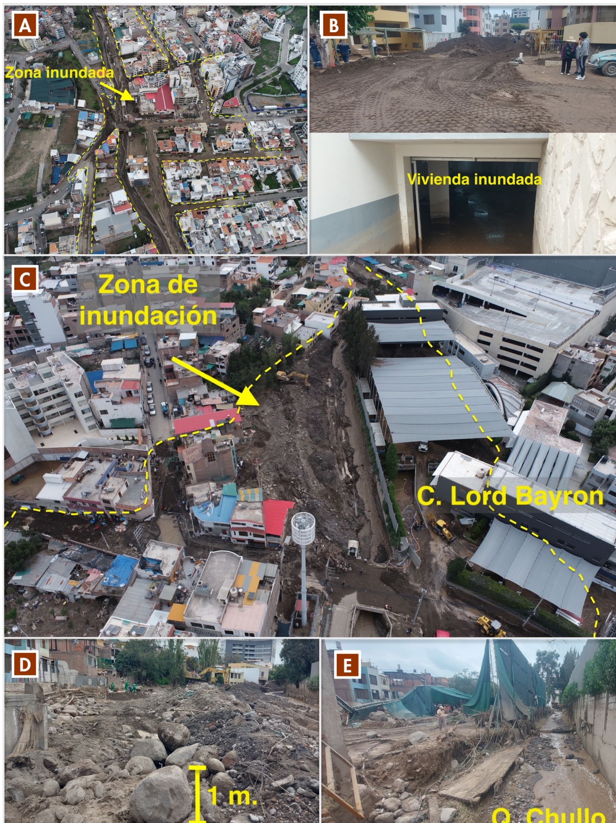
Figura 21. Vista de la quebrada Chullo y áreas aledañas. A y B) Urbanizaciones Los Ángeles de Cayma y Los Frutales, afectadas por desbordes e inundaciones. C) Desborde de la torrentera Chullo en la urbanización León XIII, con afectación al colegio Lord Byron. D y E) Cancha deportiva particular en la zona de León XIII, cubierta de lodo, sedimentos y bloques de más de 1 m de altura tras el paso del lahar.
