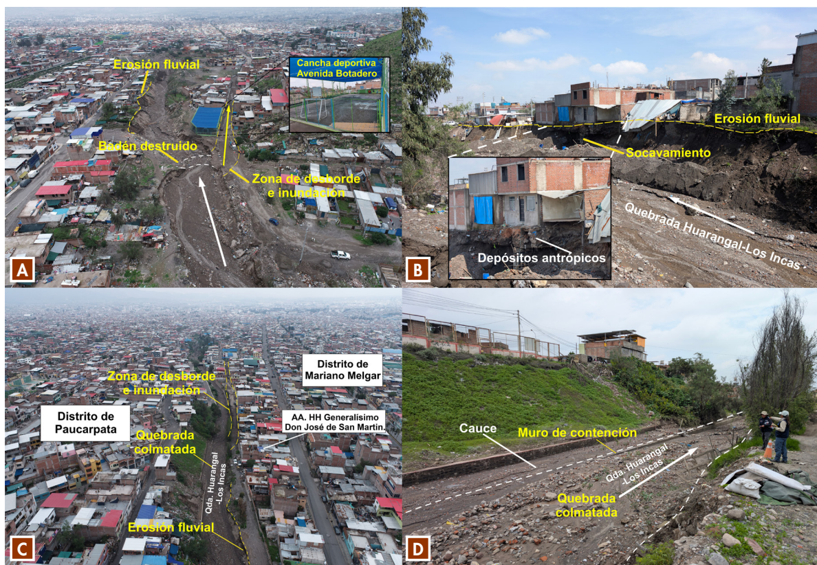
Figura 26. Vista de la quebrada Huarangal-Los Incas y áreas aledañas. A) Socavamiento de las laderas de ambos márgenes de la quebrada. B) Vivienda en el sector de Los Pinos colgada sobre el talud. C) Desborde del lahar en el A. H. Generalísimo Don José de San Martín. D) Colmatación de la quebrada en el A. H. Generalísimo Don José de San Martín.
