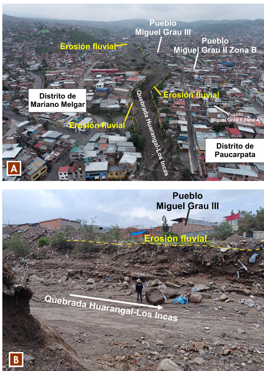
Figura 23. Vista de la quebrada Huarangal-Los Incas. A) Erosión de las márgenes de la quebrada en el distrito de Paucarpata. B) Socavamiento en el sector de Pueblo Miguel Grau III.
