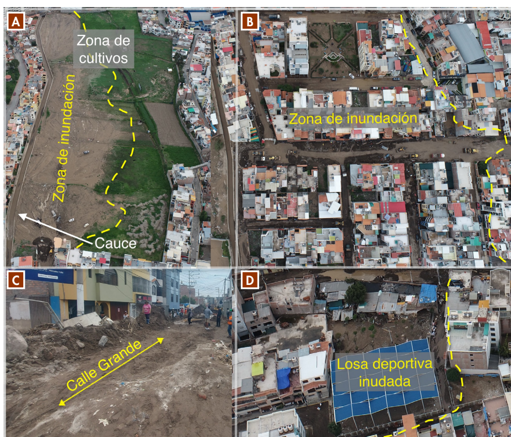
Figura 17. Vista de la torrentera Chullo en las urbanizaciones San Agustín, Cooperativa de Abogados y Los Gladiolos. A) Zona de cultivos inundados. B) Urbanizaciones San Agustín y Cooperativa de abogados con presencia de lodo. C) Calle Grande con presencia de rocas y lodo, y viviendas afectadas. D) Losa deportiva n.º10 completamente inundada con lodo.
