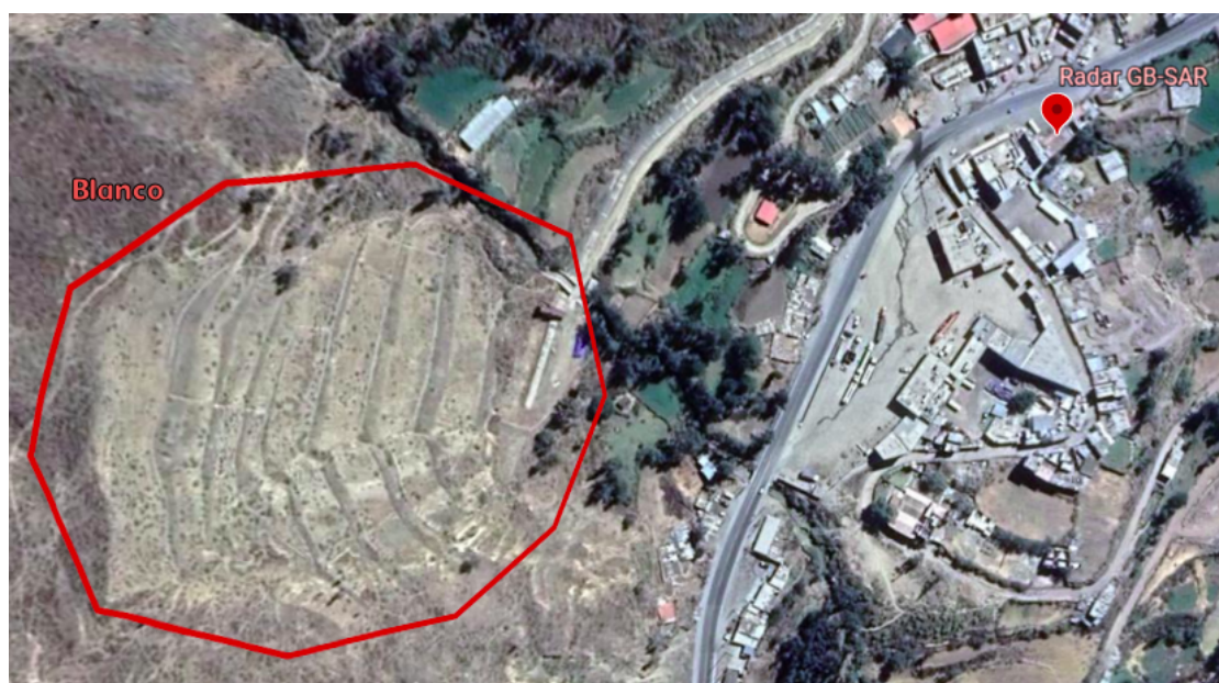
Figura 5.21: Cerro Pucruchacra, vista aérea. Se muestra el blanco y la ubicación aproximada del radar GB-SAR. (Fuente: Google Maps)
