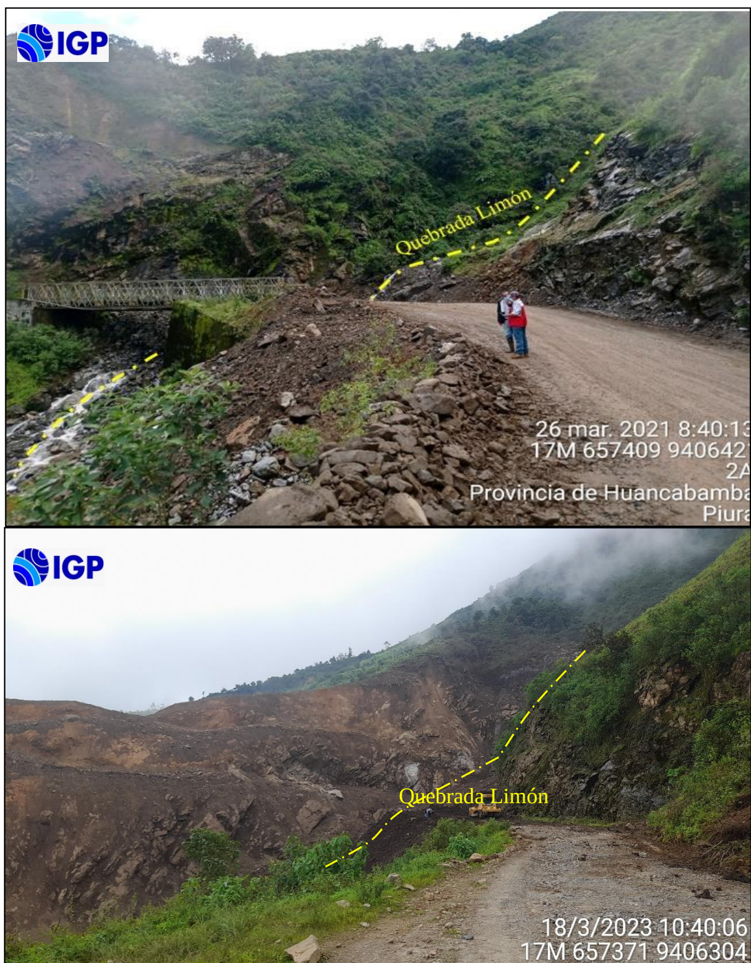
Figura 11.- Vista del Puente Fierro (Km 88+700 de la vía Canchaque – Huancabamba), la imagen superior fue presentada por IGP en el año 2021 donde se indicó susceptibilidad a la ocurrencia de flujos de detritos y la imagen inferior pertenece al año 2023 donde se visualiza el colapso del puente por ocurrencia de flujo
