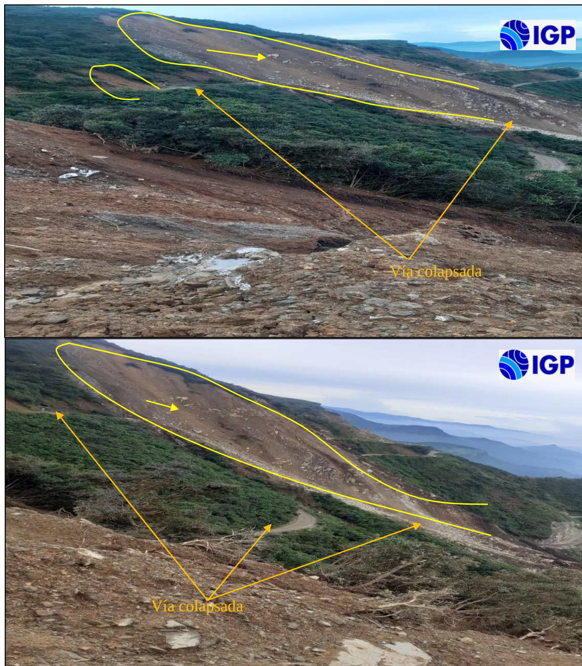
Figura 10.- Deslizamiento ocurrido en las nacientes de la subcuenca Limón, la imagen de la izquierda muestra la zona de arranque, mientras que, la imagen de la derecha evidencia la afectación de la plataforma de la vía Canchaque – Huancabamba. Fuente: Pobladores de Canchaque
