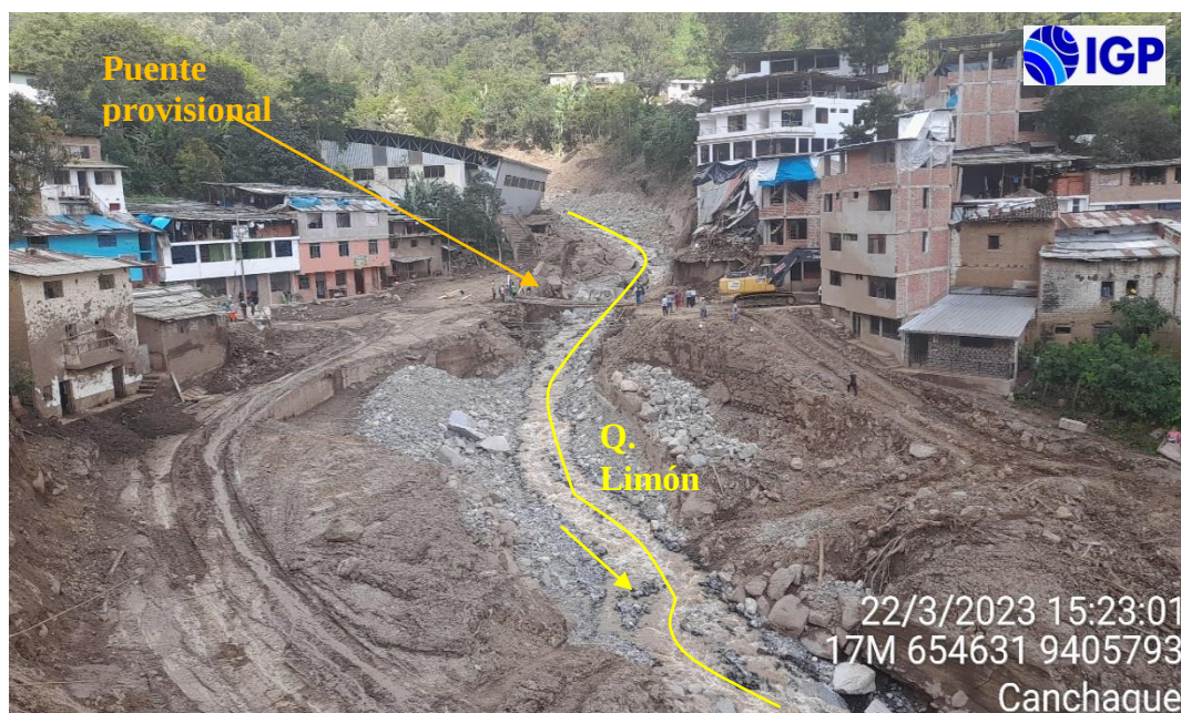
Figura 16.- Vista de puente peatonal provisional instalado ante el colapso del puente de la quebrada Limón en las inmediaciones del barrio La Villa
