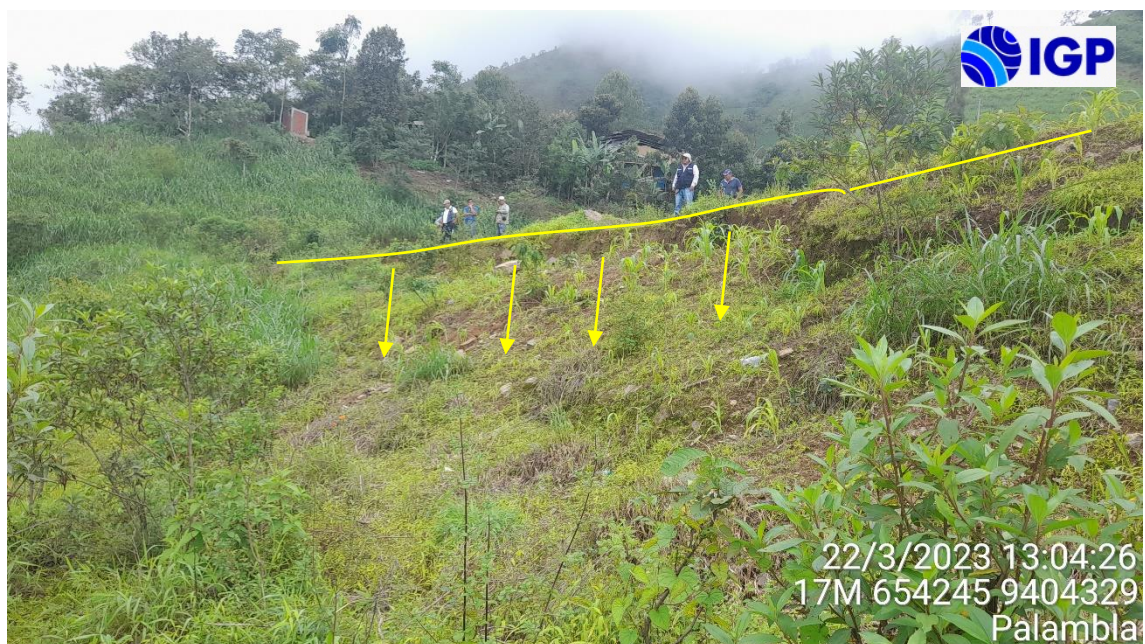
Figura 25.- Zona de arranque de fenómeno caída de suelos o derrumbe (debajo de línea amarilla) identificado en las inmediaciones del DME 04
