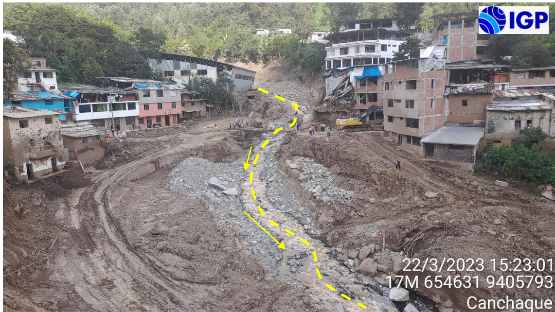
Figura 3.- Cauce aluvial (línea discontinua amarilla) de la quebrada Limón en las inmediaciones del sector La Villa en la ciudad de Canchaque
