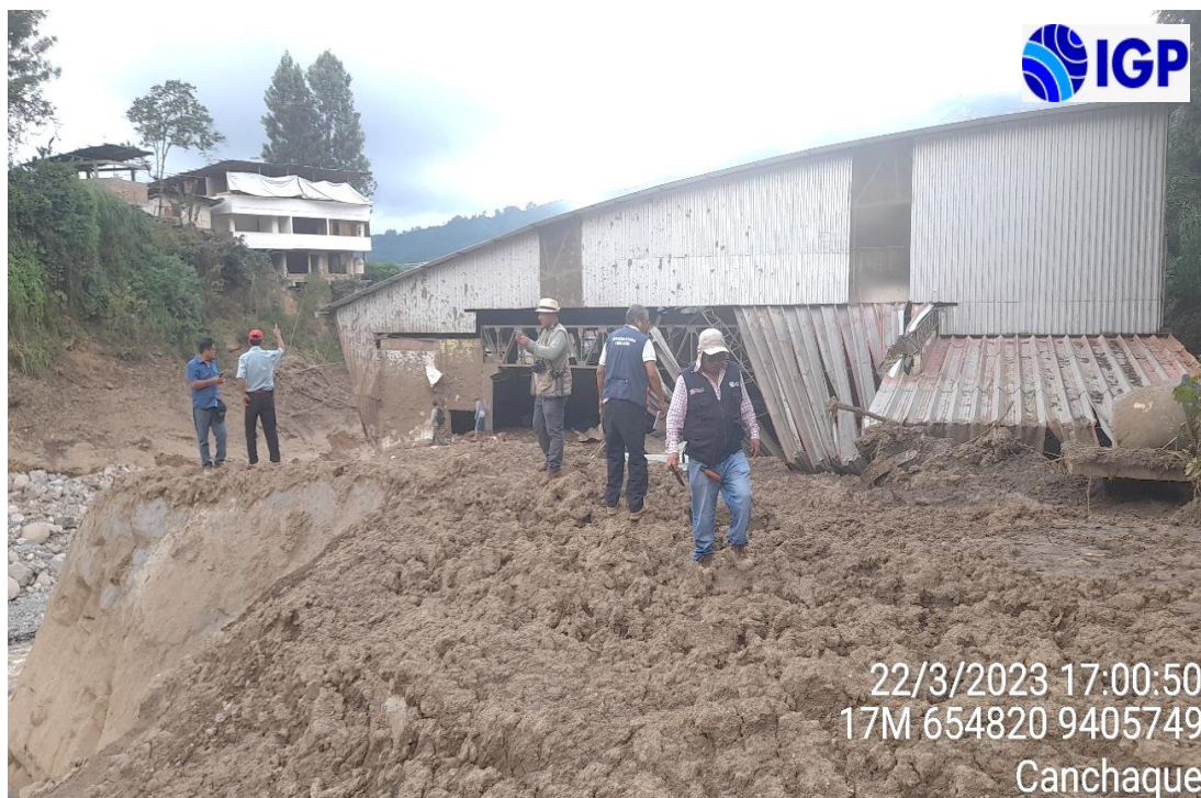
Figura 15.- Coliseo deportivo Canchaque ubicado en el margen derecho de la quebrada Limón, que ha sido afectado parcialmente (colapso de paredes) por el ingreso de los materiales aluvionales transportados el flujo
