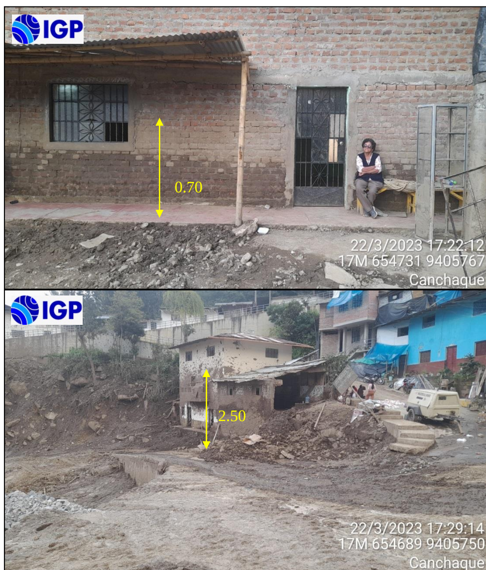
Figura 17.- Evidencia de la altura que alcanzó el flujo en las inmediaciones del margen derecho de la quebrada Limón, la imagen superior muestra alturas de 0.70 m, mientras que la imagen inferior muestra que el flujo alcanzó alturas de 2.50 m en el barrio La Villa.
