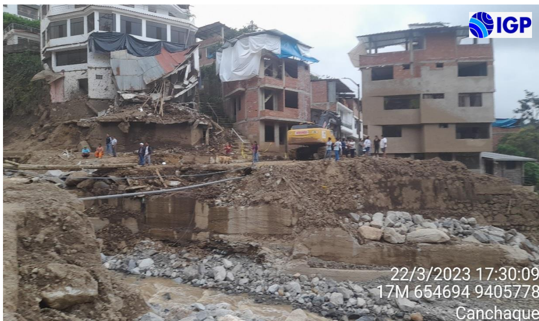
Figura 18.- Afectación de hotel Titanic (edificación de color blanco) y vivienda con evidencias de afectación severa por el paso del flujo, hasta el tercer piso, debido al impacto del huaico en un meandro situado en el margen izquierdo de la quebrada Limón (inmediaciones del puente Limón colapsado)
