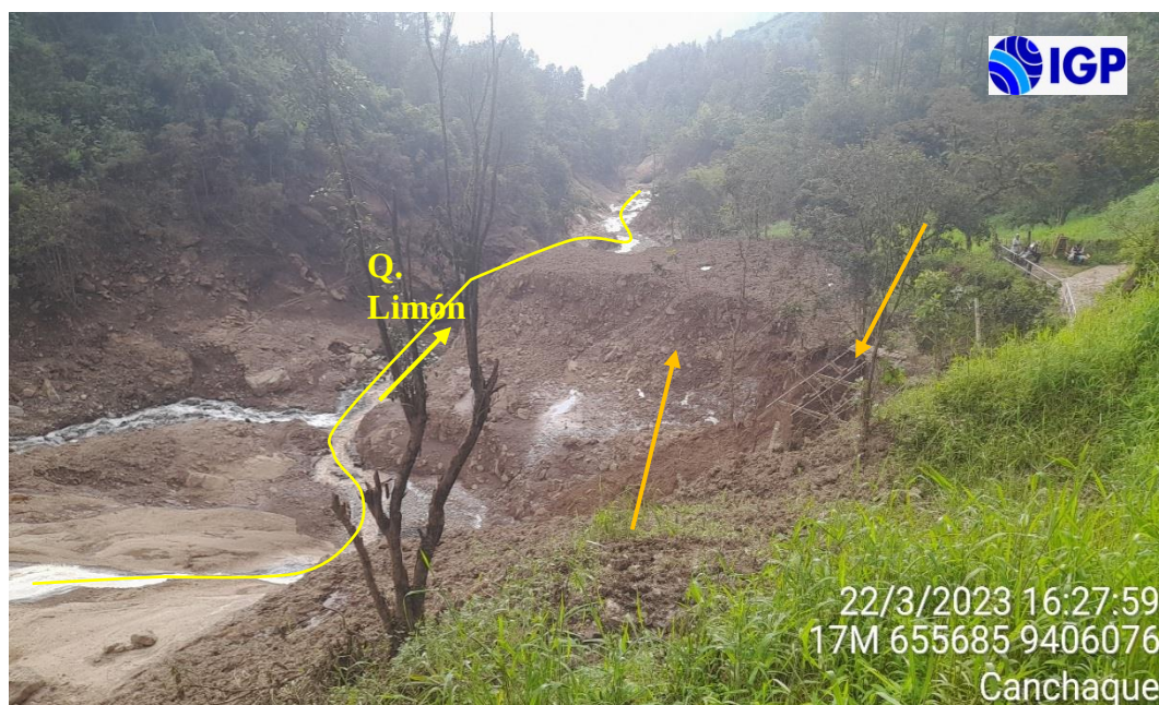
Figura 12.- Quebrada Limón aguas abajo del sector los peroles de Mishahuaca donde los materiales transportados por el flujo han dañado servicios higiénicos del lugar turístico y han depositado materiales en el margen derecho del cauce
