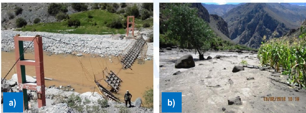
Figura 25.- a) Puente peatonal de ~50 m de largo destruido durante el desembalse de la laguna formada en el río Tambo el día 13 de febrero de 2016; b) Terrenos de cultivo destruidos por el lahar del 12 de febrero en el sector de Huarina, cerca de la confluencia de los ríos Ubinas y Anascapa.
