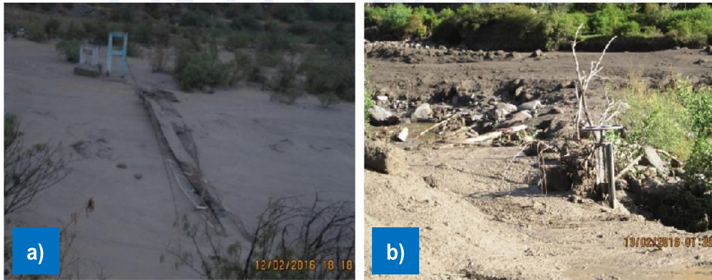
Figura 23.- a) Destrucción del puente peatonal “Ánima” (Huarina), originado por el lahar del día 12 de febrero 2016 en el río Para; b) Destrucción de canales de agua en el sector de Huatagua
