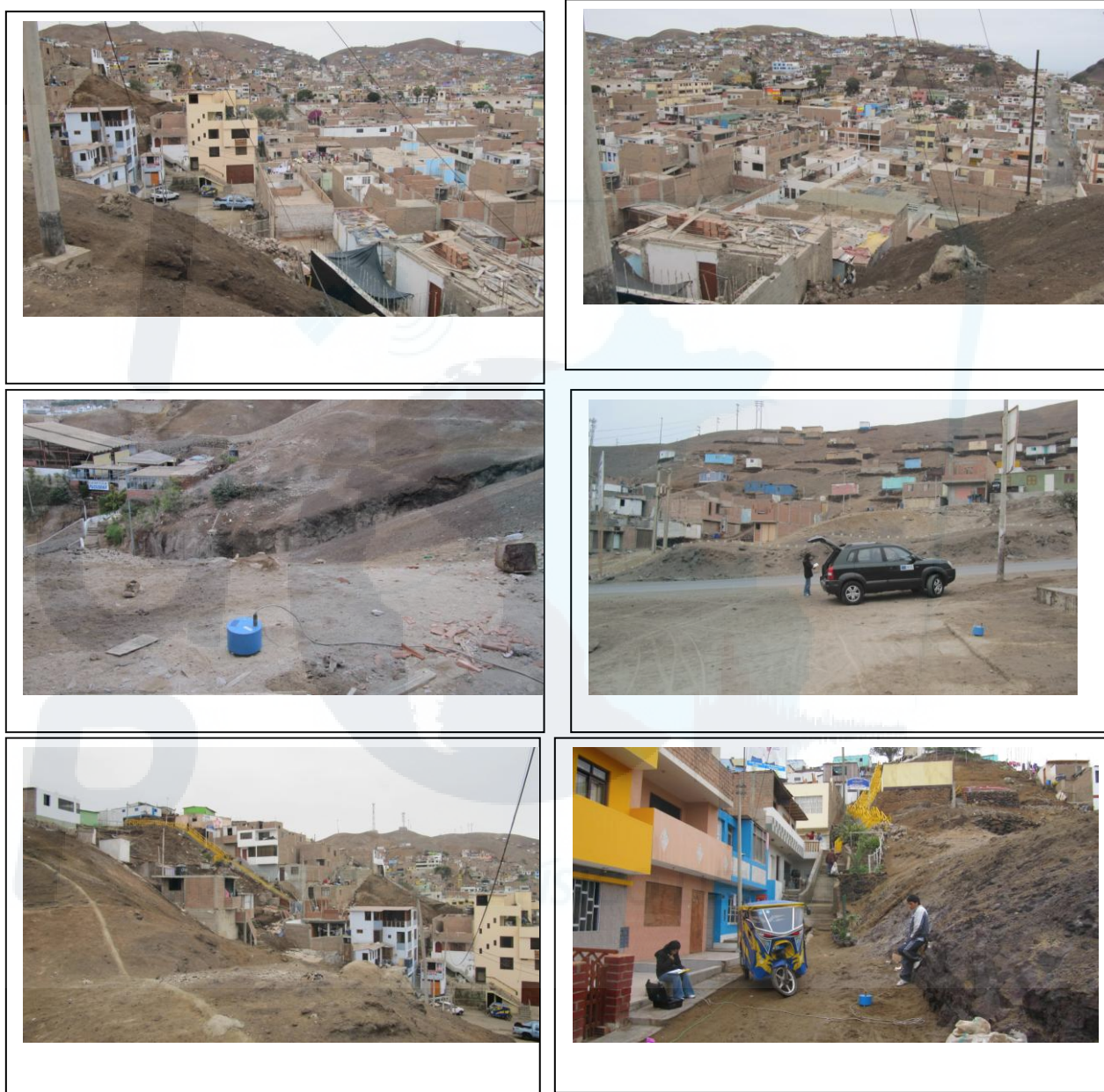
Figura 7.- Imágenes del Distrito de Pucusana. Observe en las imágenes superiores, la tugurización de la ciudad y su expansión urbana hacia los lomeríos y/o cerros. En las imágenes del medio se observan viviendas en suelos de relleno con fragmentos de material de construcción mezclados con material sedimentario y viviendas edificadas sobre rellenos con una precaria estabilización por pircas poco consistentes. En las imágenes inferiores, se observan edificaciones de material noble construidas en las pendientes de los lomeríos de forma escalonada.
