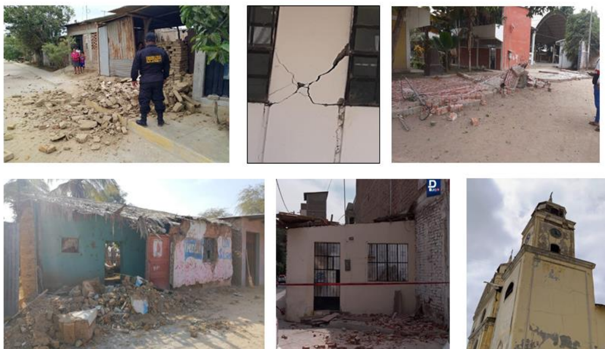
Figura 10.- Diversos tipos de daños observados en viviendas, iglesias y colegios debido a la ocurrencia del sismo de Sullana (fuente: varios medios de comunicación)
