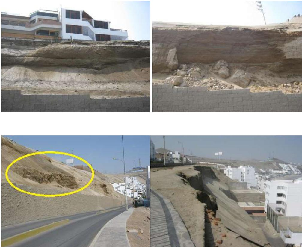
Fotografías 7.7 Erosión de laderas, percolación de aguas subterráneas y desprendimiento de bloques de suelo (registro propio, febrero -2013).
