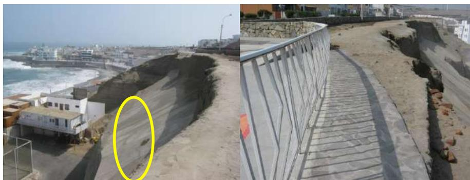
Fotografías 7.8 Fractura de obras realizadas para estabilizar el talud. Imagen derecha fractura en la base del mirador (registro propio, febrero -2013).
