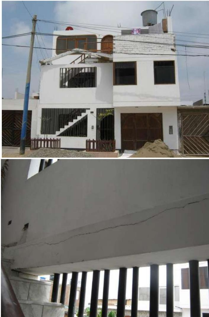
Fotografías 5.6 La imagen superior muestra una vivienda en la Urb. Santa Cruz sin mayor daño aparente, pero al ingresar se observa daño estructural en vigas (imagen inferior) (registro propio, noviembre -2012).
