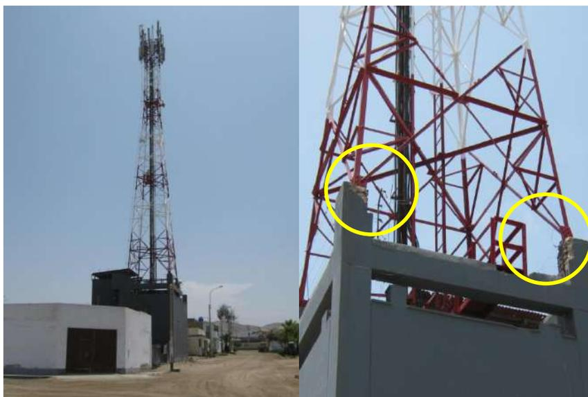
Fotografías 7.16 Antena de telefonía en la Urb. Miramar. Los círculos amarillos resaltan las bases deterioradas de la antena (registro propio, octubre -2012).
