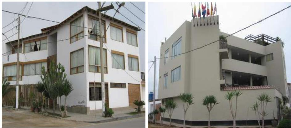
Fotografías 5.5 En la parte superior viviendas irregulares en elevación, y en la parte inferior viviendas irregulares en planta (registro propio, noviembre -2012).
