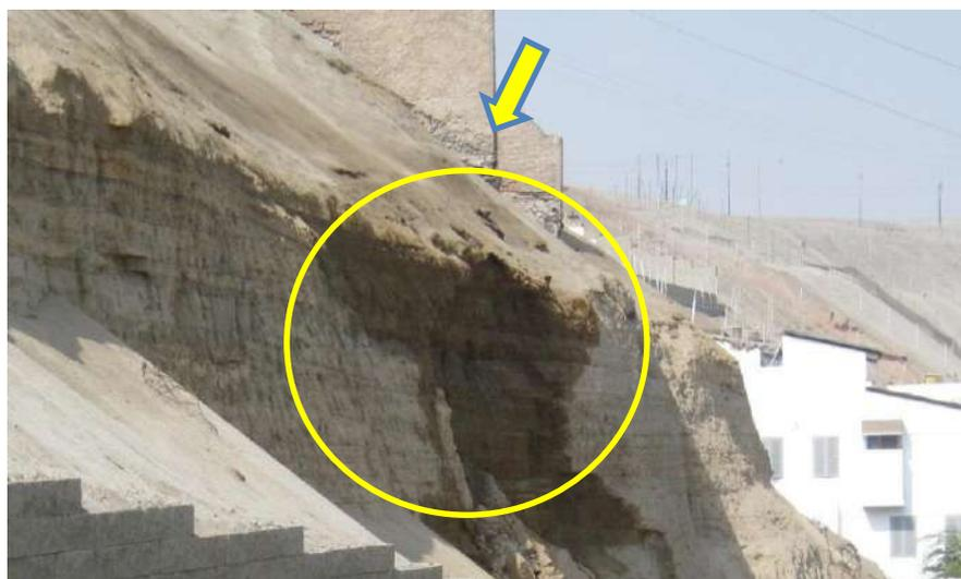
Fotografía 7.9 Humedad del suelo y muros perimétricos en mal estado en la Urb. Miramar (registro propio, febrero -2013).
