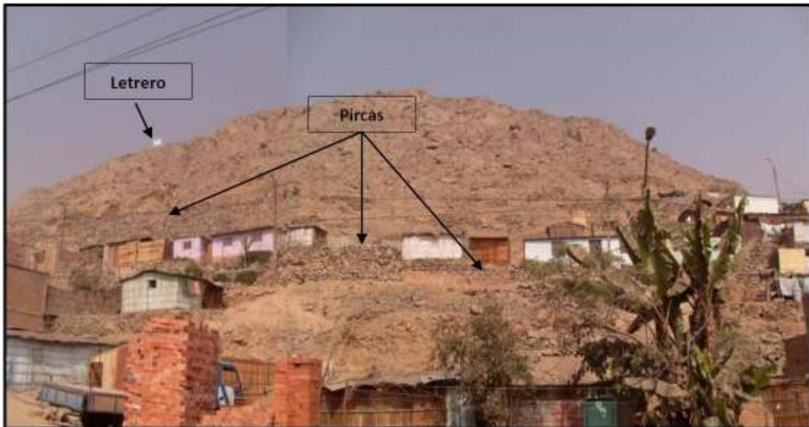
Pircas construidos a base de rocas sin cementar y que por efectos de naturaleza puede originar el colapso de estos y afectar a las viviendas.
