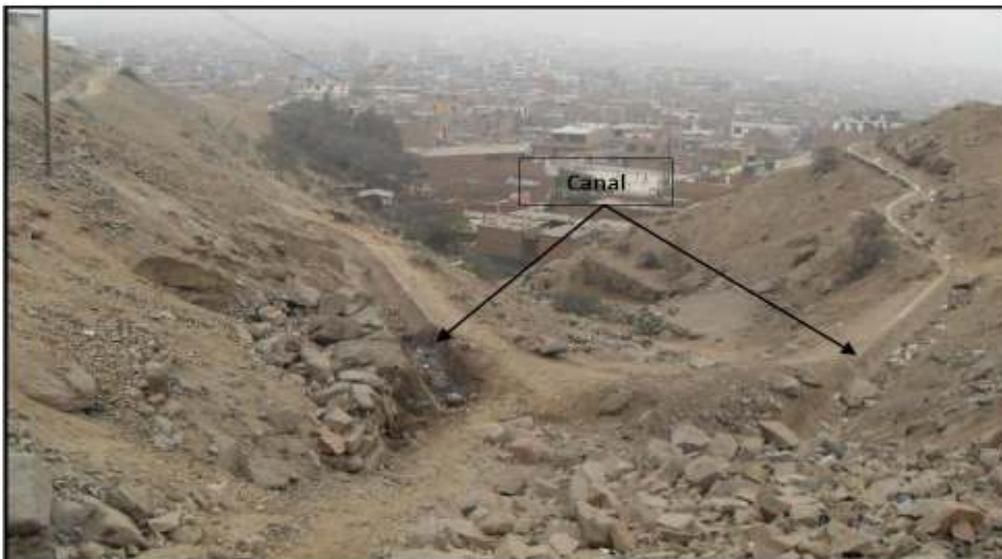
Canal de agua deteriorado por caída de rocas con arenas producto de construcción de viviendas en la parte alta.
