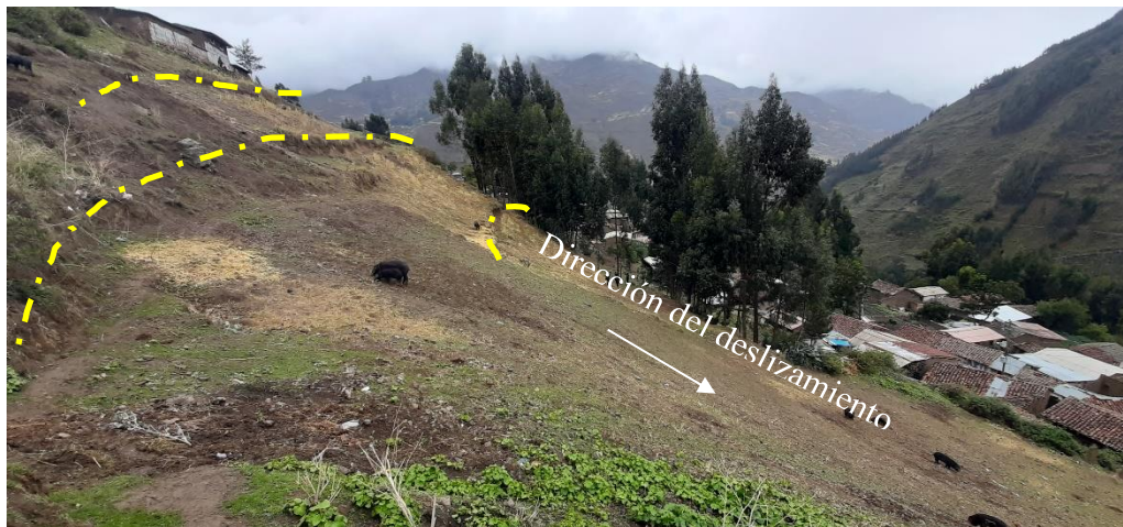
Figura 12. Escarpas secundarias (líneas amarillas discontinuas) que indican el desarrollo de un deslizamiento rotacional de tierra en el Centro Poblado Challhuayaco. La flecha blanca indica la dirección de deslizamiento.
