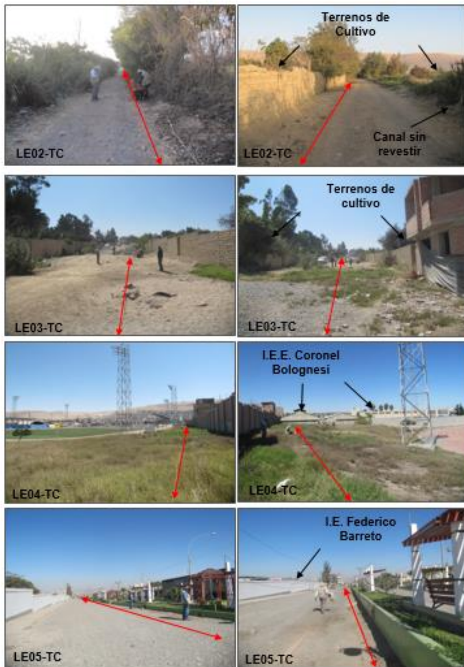
Figura 22: Vista de las líneas eléctricas LE02-TC, LE03- TC, LE04- TC y LE05- TC.
