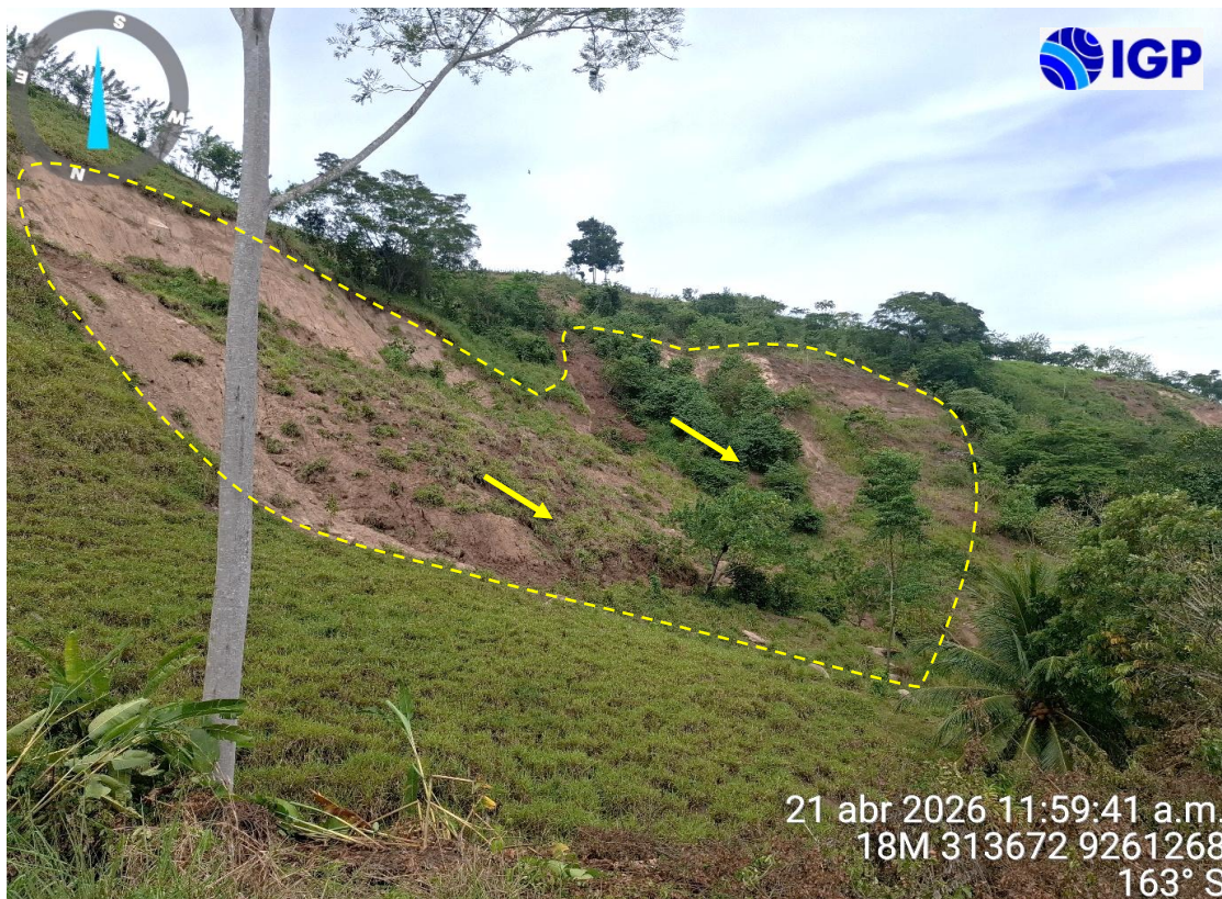
Figura 16.- Depósito coluvio – deluvial conformado por material suelto (bloques de roca subredondeados, arenas y limos) identificados a 312 m al noreste del caserío Eladio Tapullima
