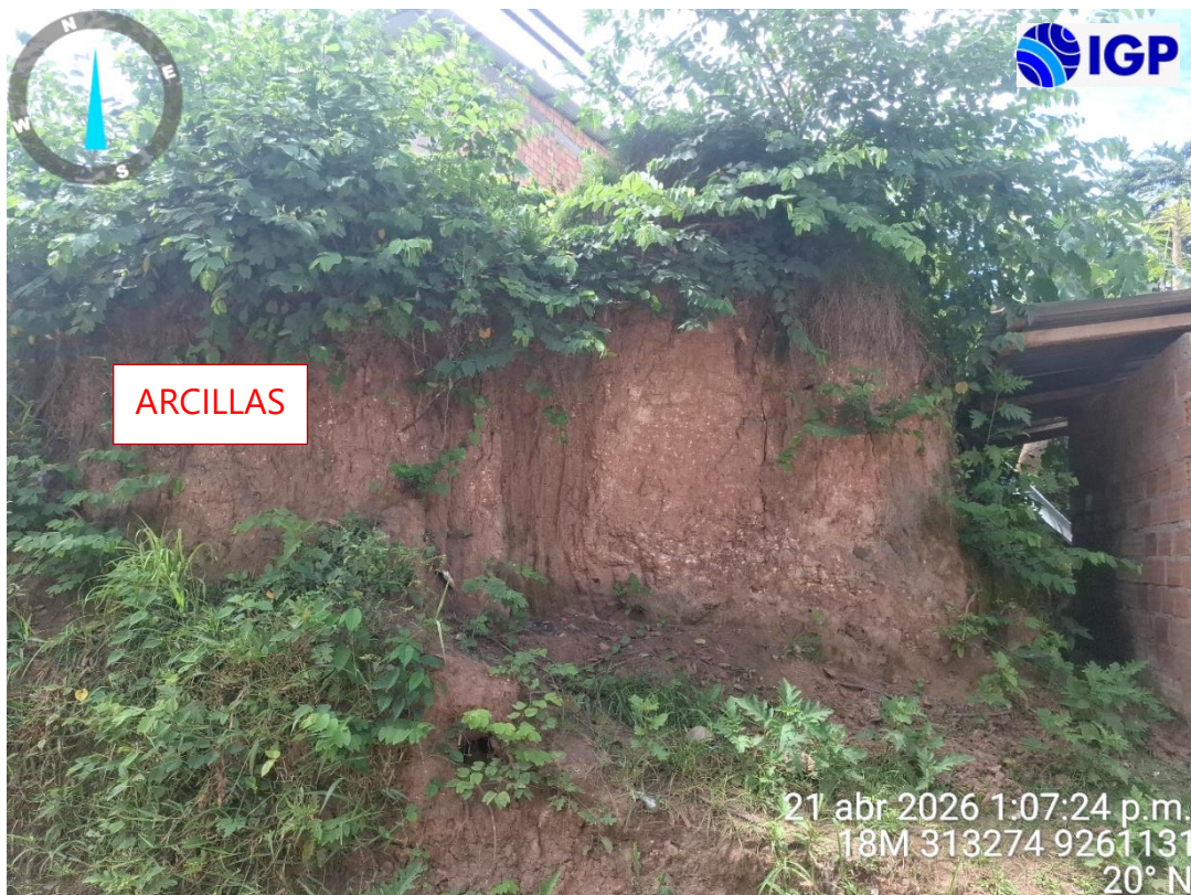
Figura 13.- Arcillas marrones a rojizas que conforman unidad geológica depósito aluvial cuyos espesores varían de 2 a 6 m que se habría originado por erosión de lodolitas
