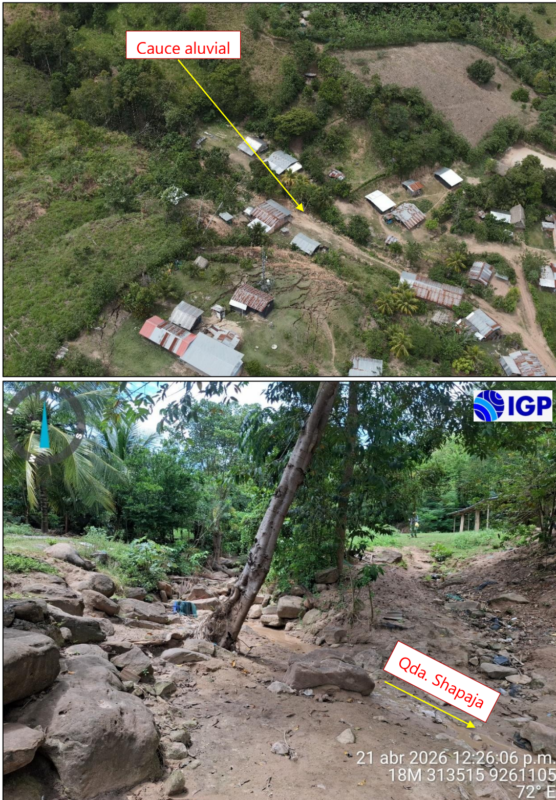
Figura 4.- Unidad geomorfológica cauce aluvial (quebrada Shapaja) que intercepta al caserío Eladio Tapullima en las inmediaciones de las viviendas
