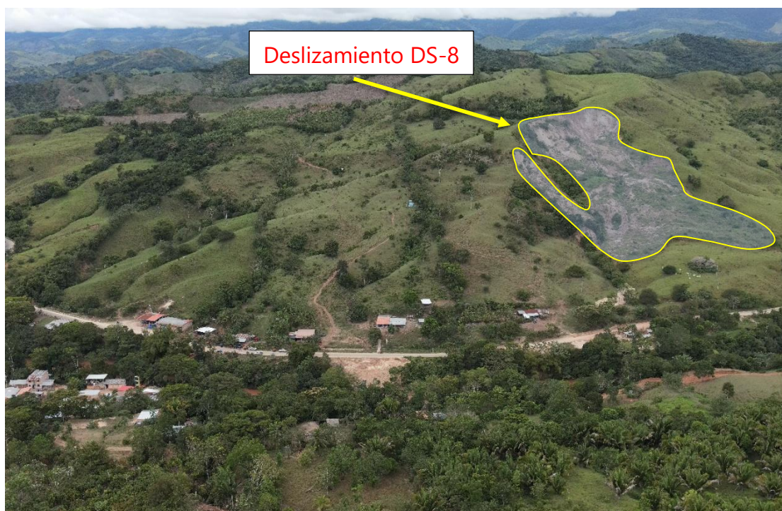
Figura 31.- Deslizamiento DS-08 identificado en las laderas situadas en el margen derecho del río Sisa (frente al caserío Eladio Tapullima).
