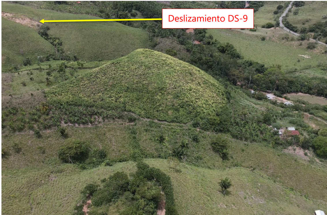
Figura 32.- Ubicación de Deslizamiento DS-09 identificado en las laderas situadas a 760 m al sureste del caserío Eladio Tapullima
