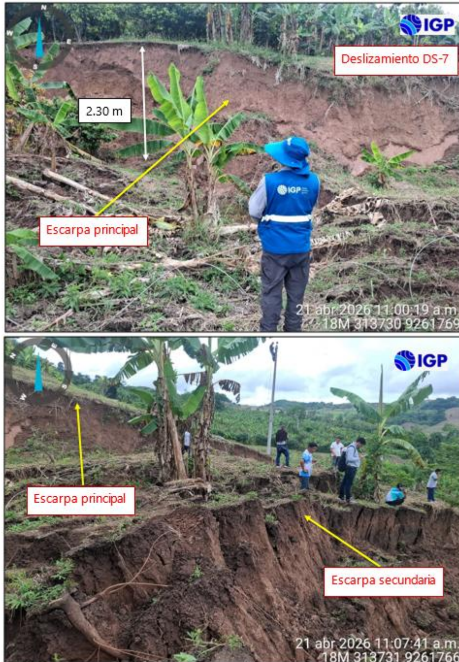
Figura 30.- Deslizamiento DS-07; la escarpa principal generada el 15 de abril de 2026 muestra un retroceso aproximado de 27 m con respecto a la escarpa formada en 2025 cuando colapsó poste de tendido eléctrico
