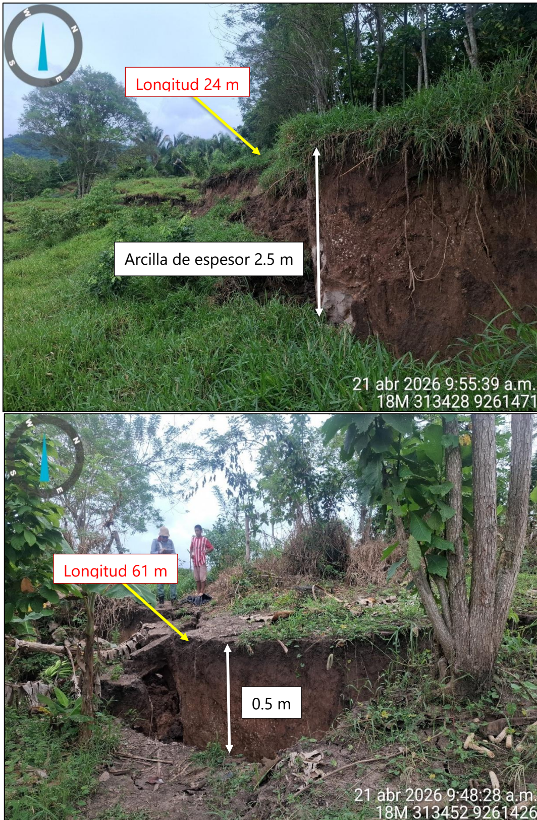
Figura 23.- Grietas en la parte media del cuerpo del deslizamiento que presentan profundidades mayores a los 2 m.
