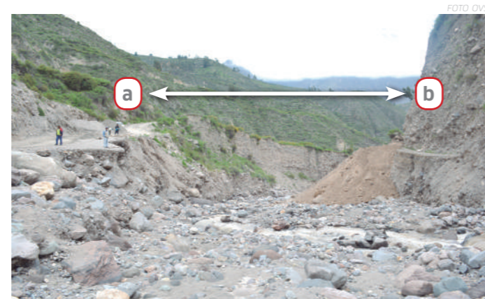
Figura 05.- El lahar arrasó con este tramo de camino, en las coordenadas 241E – 8 186 432N.
