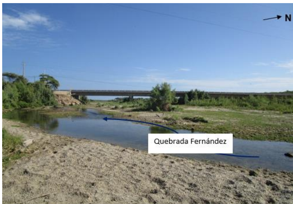
Figura 5: Lecho aluvial de la quebrada Fernández
