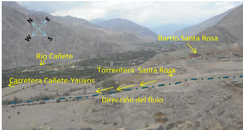
Figura 27: Torrentera Santa Rosa en las cercanías del barrio del mismo nombre.
