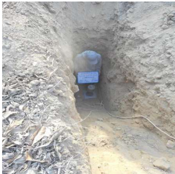
Figura 5: Calicata elaborada en la ciudad de Lunahuaná y ensayo de densidad de suelo mediante el método del Cono de Arena.
