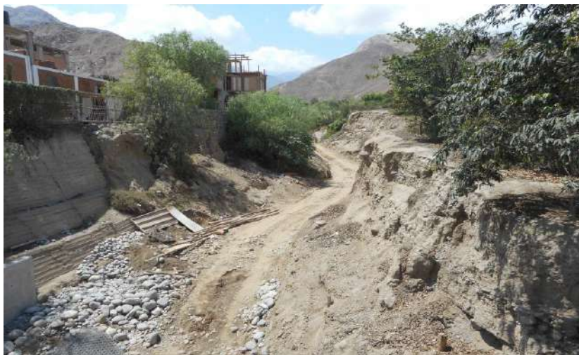
Figura 28: Torrentera Jita en proceso de enrocado mediante el uso de gaviones para evitar la erosión de sus márgenes.
