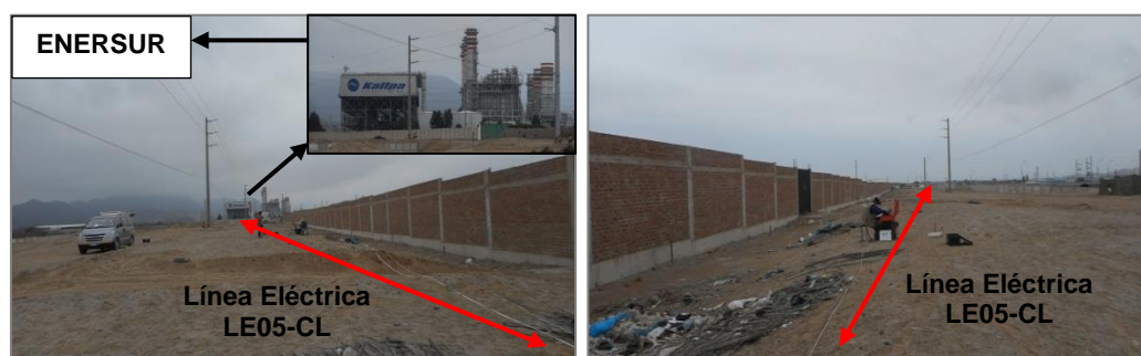
Figura 20: Vista de la línea eléctrica LE05-CL
