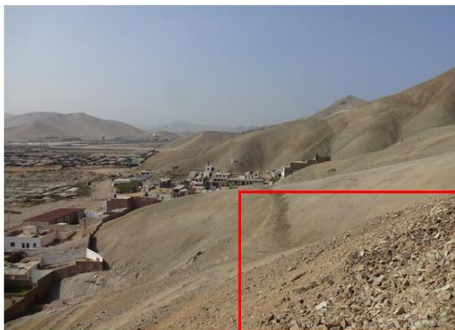
Figura 14: Depósitos coluviales, en el sector Las Salinas, que afectan a la zona urbana en mención.
