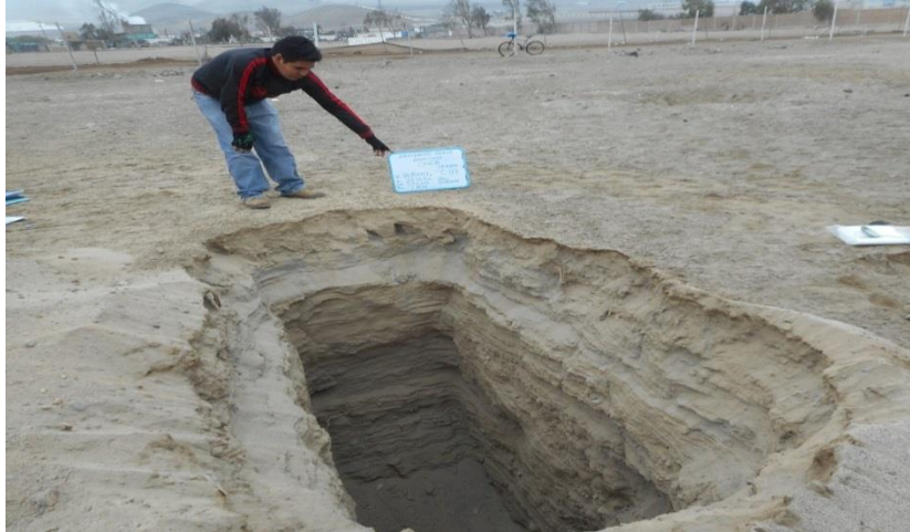
Foto 32: Elaboración de calicata (C-03), ubicada en la urbanización San Hilarión.
