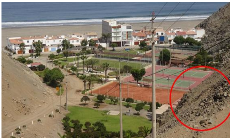
Figura 24: Caída de rocas, círculo color rojo, debido a la actividad antrópica que desestabilizó el talud para construir una vía de acceso desde el sector Las Salinas.
