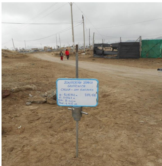
Figura 34: Elaboración de ensayo de DPL, ubicado en el sector Las Salinas-Aguita de Coco.
