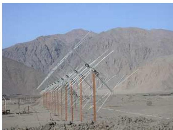
**Figura 4.5.** Arreglo de antenas para la transmisión desde Jicamarca (16 antenas Yagi)
