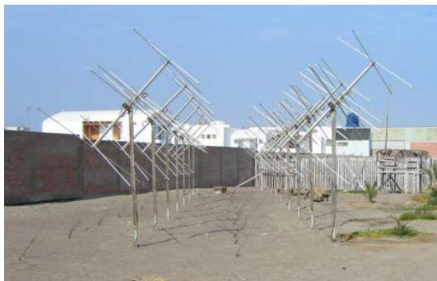
**Figura 4.7.** Arreglo de antenas para la recepción en Paracas (2x8 antenas Yagi)
