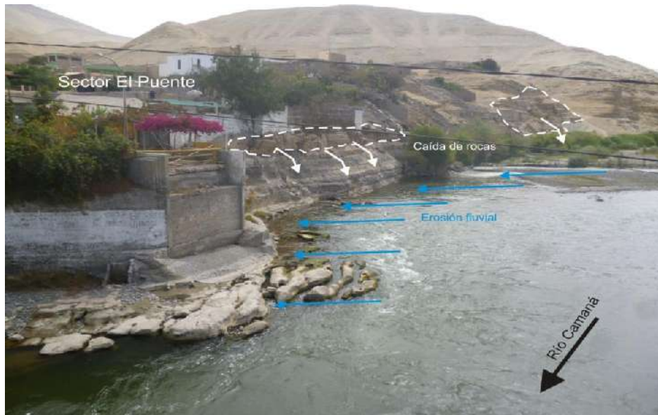
Figura 43: Erosión fluvial en materiales arenosos, sector El Puente de Fierro. El afloramiento rocoso muestra un alto grado de fracturamiento, lo cual facilita la acción erosiva del río y permite el colapso de grandes bloques de roca.
