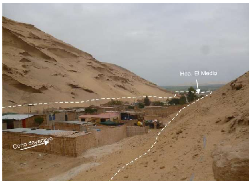
Figura 33: Cono de deyección ocupado por viviendas como Hacienda el Medio.
