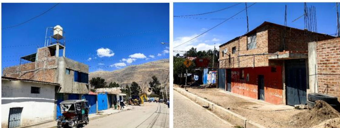
Figura 38.- Izquierda: Edificaciones de múltiples niveles (1 y 2 pisos) y distintos materiales sin daños observables. Derecha: Vivienda altamente vulnerable de 2 niveles sin daños aparentes.
