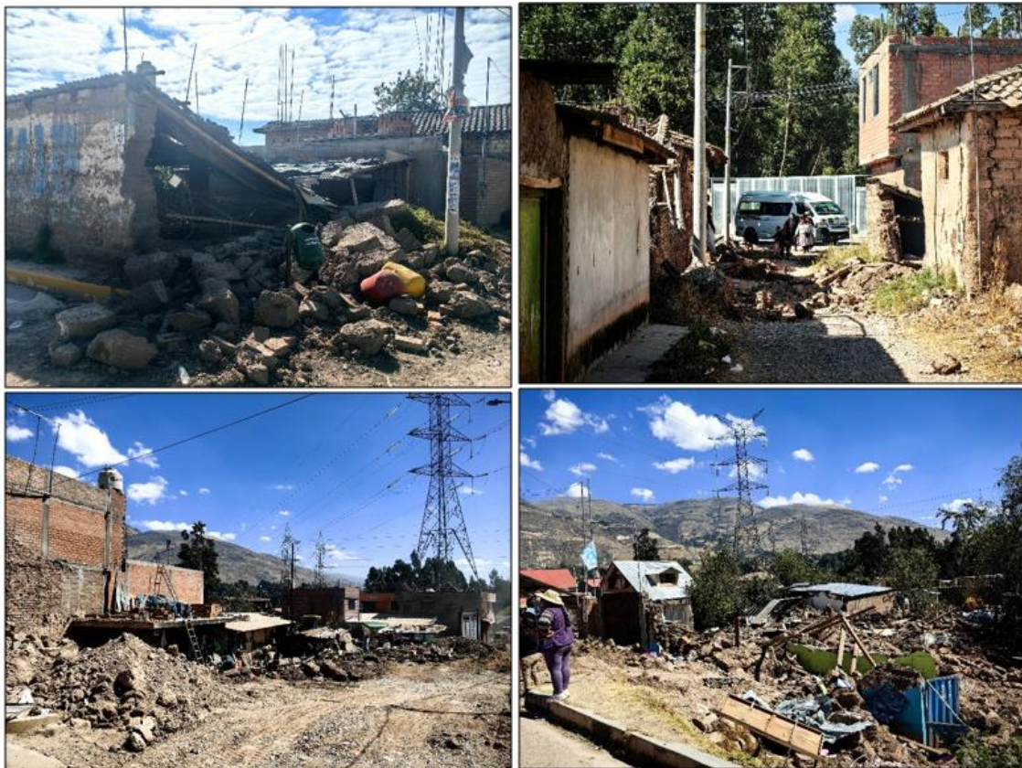
Figura 35.- Viviendas de adobe dañadas y demolidas por la Municipalidad Provincial de Huancayo
