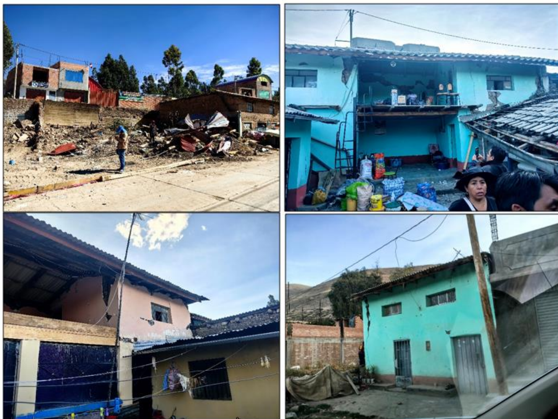
Figura 41.- Viviendas de adobe demolidas y con daños moderados tras el sismo
