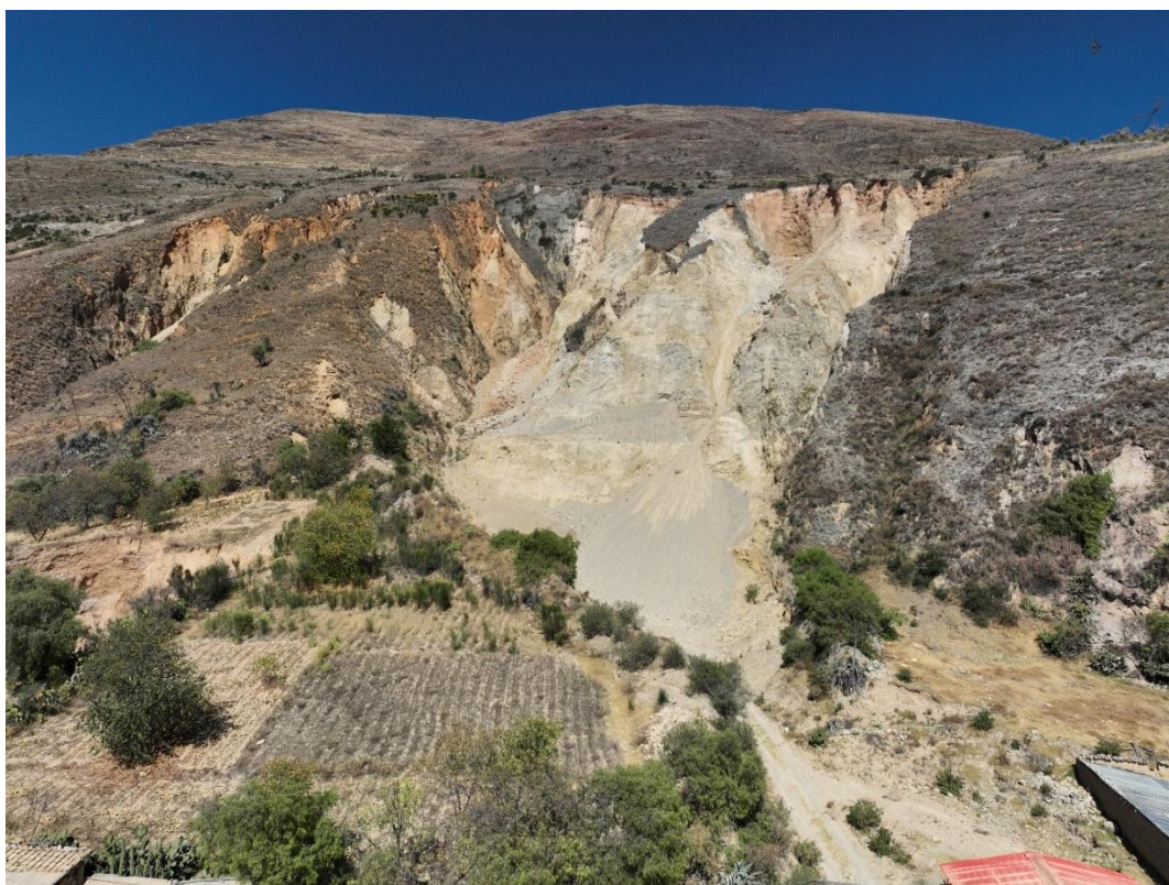
Figura 24.- Vista panorámica de las zonas de derrumbes hacia terrenos agrícolas y viviendas.
