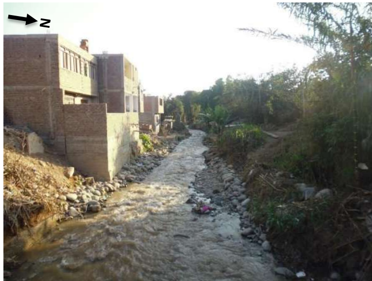
Figura 35: Quebrada Pócoto paralela a la Av. 9 de Diciembre en donde se evidencia la erosión lateral de dicha quebrada en la zona urbana de San Vicente de Cañete
