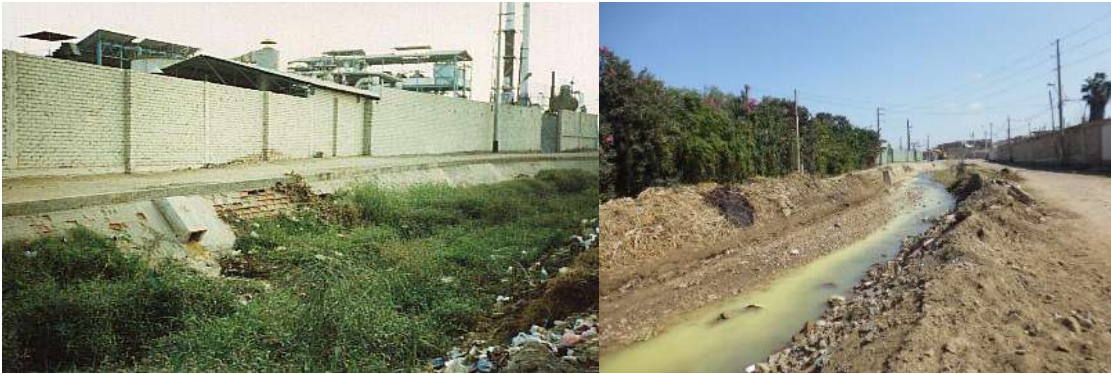
Figura 33: Desechos sólidos en el lecho de la acequia Ihuanco 2015 (derecha) y 2002 (izquierda).
