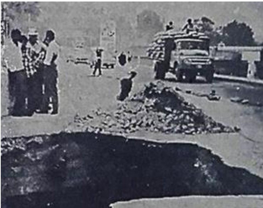
Chaclacayo, 17/01/1970: Daños de las torrentosas aguas del río Rímac causó daños en el puente Los Ángeles (Diario La Crónica, 1970)
