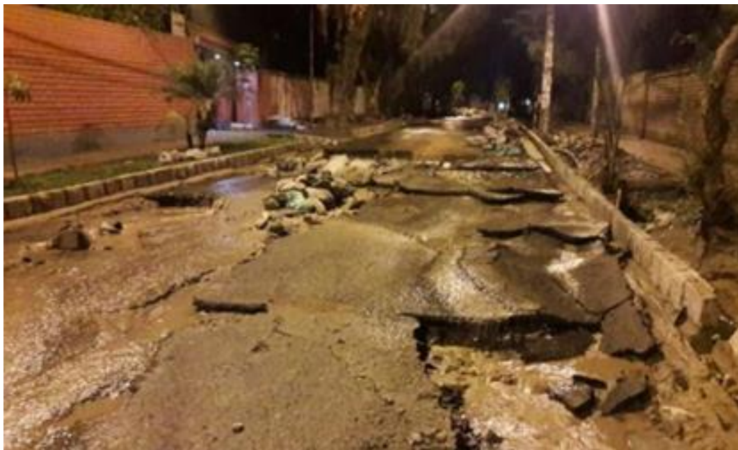
Figura 42: Calle Los Laureles destruida por el huayco, ubicada a la altura del kilómetro 26 de la Carretera central, en el distrito de Chaclacayo (El Comercio. 25/01/2017)
