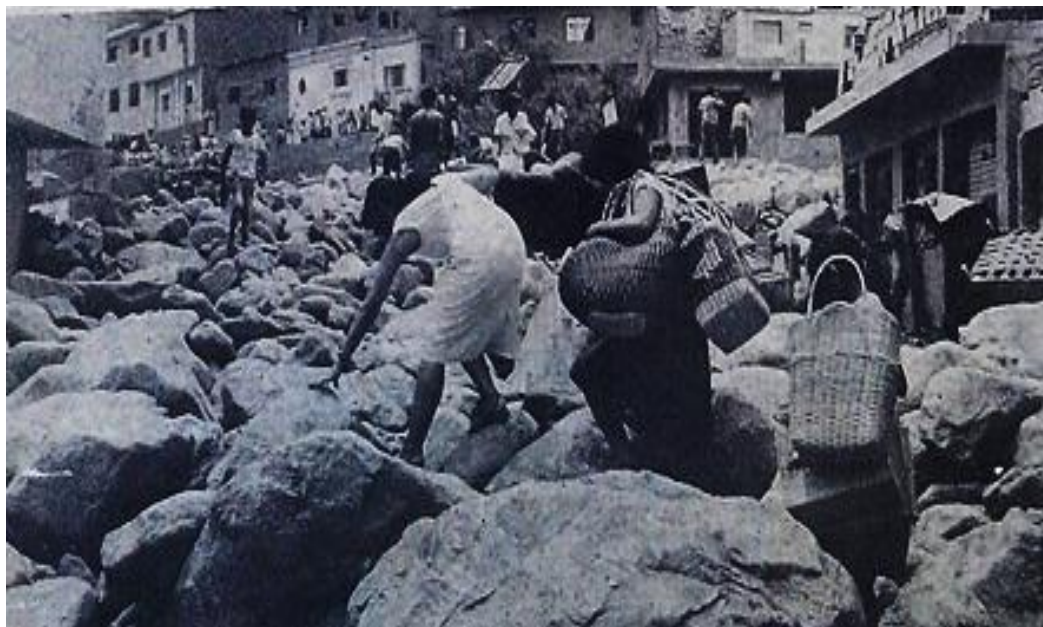
Chosica, 11/03/1987: La vía Moyopampa-Casapalca fue arrastrada por el devastador huayco que cayó sobre la zona de Santa Eulalia (Diario el Comercio)-
