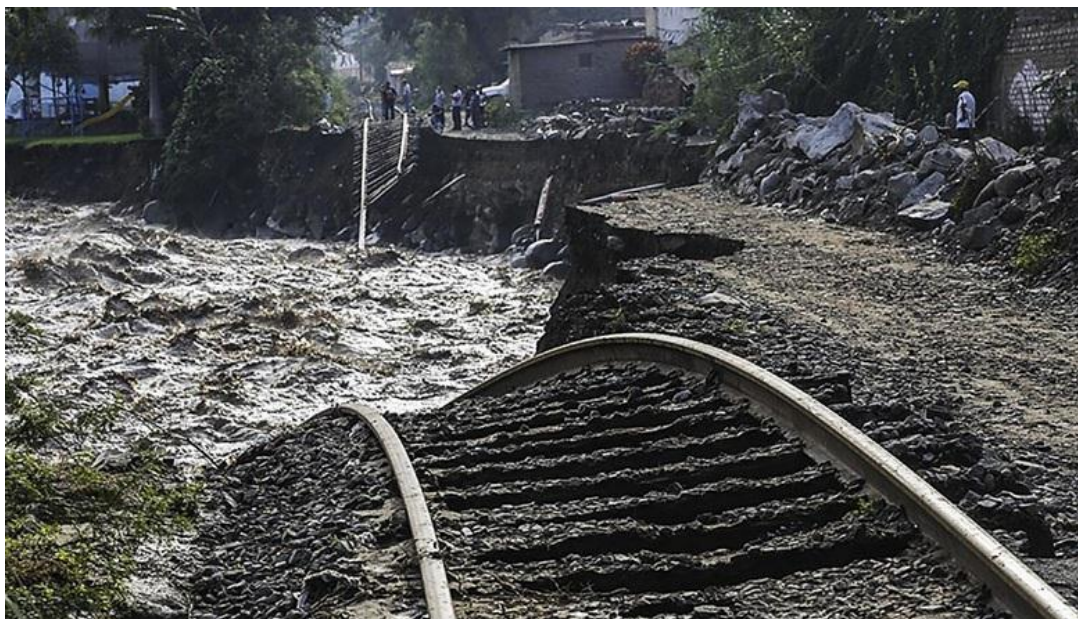
Chaclacayo, 16/04/2017: Destrucción de la vía férrea a la altura del puente Los Ángeles. Fuente: Diario El Comercio 2017.
