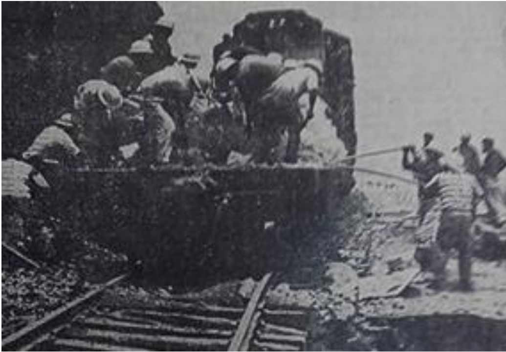
Huarochirí, 18/01/1970: Salida del Tunel Purhuay, en el kilómetro 45 del Ferrocarril Central. Las aguas del río Rímac ingresaron al túnel con gran violencia, destruyendo la vía férrea (Diario El Comercio)
