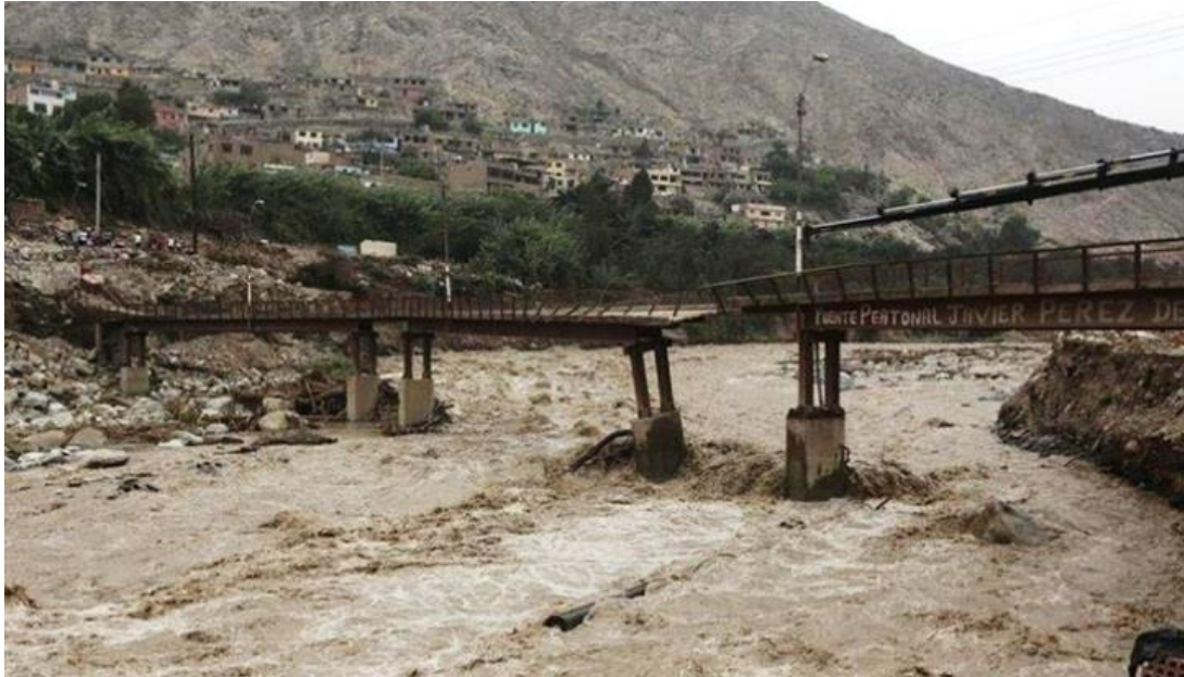
Chaclacayo, 19/03/2017: La localidad Alto Huampaní quedó parcialmente aislada por rotura del puente Javier Pérez de Cuellar, a consecuencia del alto caudal del río Rímac y los huaycos (Diario Perú 21)
