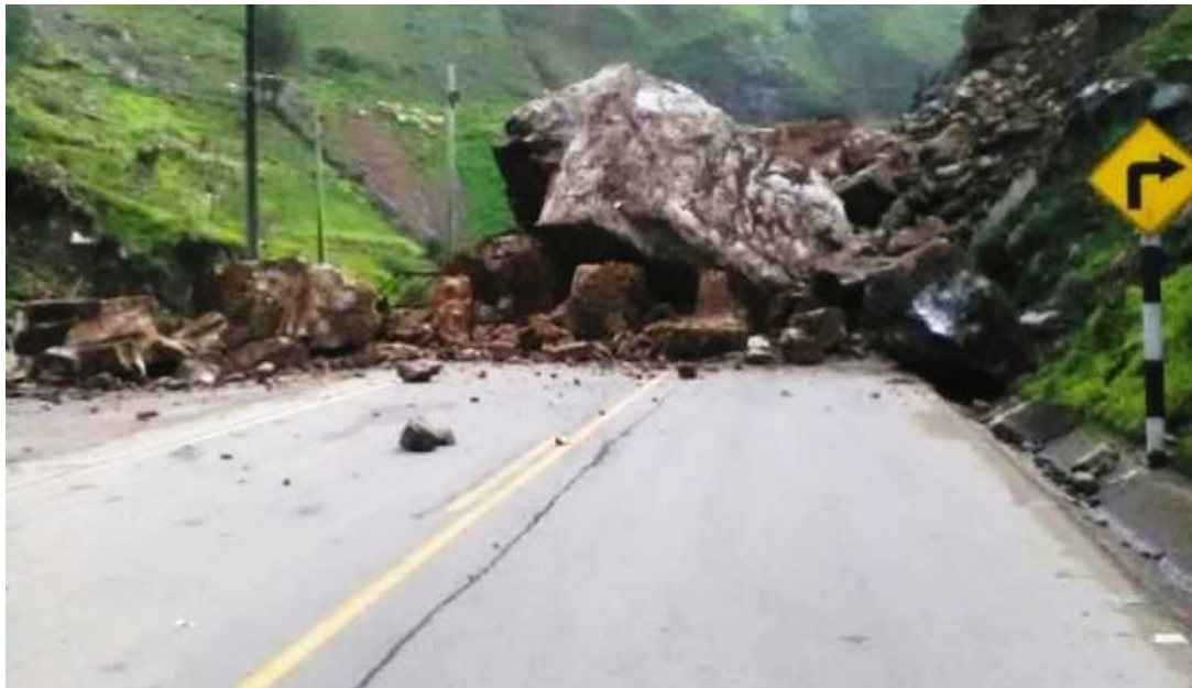
Huachirí, 17/03/2017: Varios derrumbes afectaron la Carretera Central por las constantes lluvias y huaycos que se produjeron por El Niño costero 2017 (Diario Perú 21).
