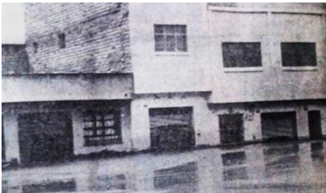
Figura 16: Vivienda inundada a más de un metro de altura, ubicada en la plaza de Armas de Matucana. (Diario El Comercio. 24/02/1983).
