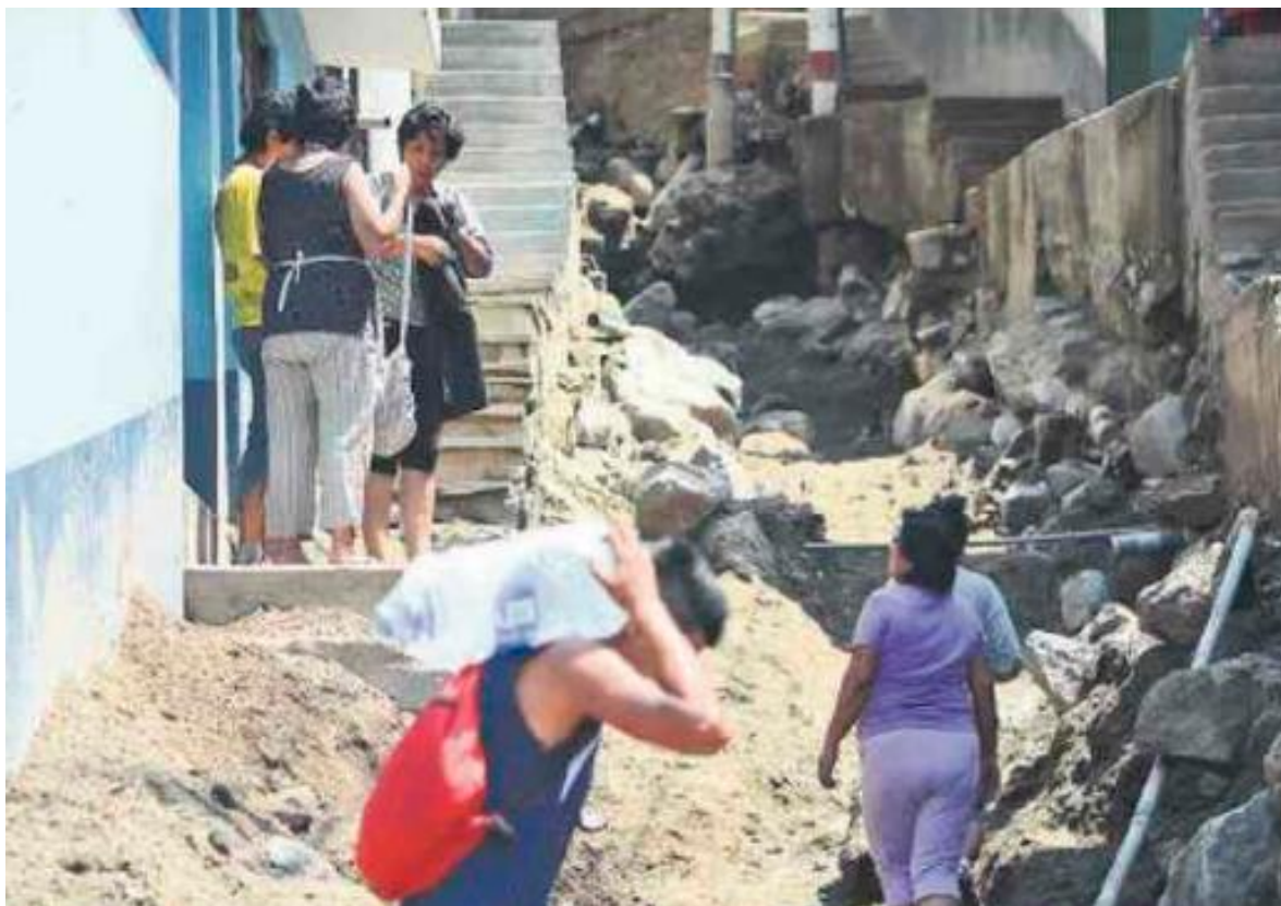
Figura 44: Calle erosionada por la activación de la quebrada Libertad. Diario El Correo. 28/02/2017.
