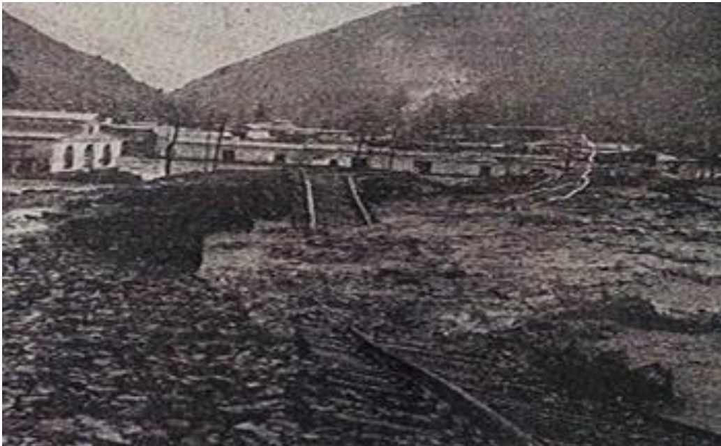
Matucana, 16/02/1959: El torrentoso río Rímac luego de quebrar el muro de defensa, socavó el terraplén de la vía férrea y penetró en forma incontenible hacia el centro de la ciudad (Diario El Comercio)
