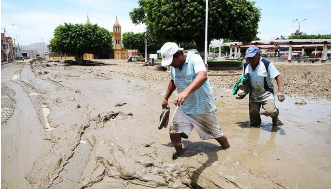
Ricardo Palma, 23/03/2017: Desborde del río Rímac inundó completamente el km 44 de la Carretera Central, en la imagen se observa la afectación de viviendas y negocios, de la zona de Cupiche (Recuperado de página web https://peru.com/actualidad/mi-ciudad/desborde-rio-rimac-inunda-kilometro-44-carretera-central-noticia-504793-1600240 )
