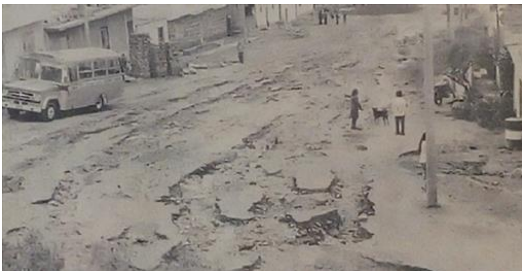
Figura 13: Fuertes lluvias causaron daños de consideración e impidieron el tránsito vehicular en los kilómetros 28 y 34 de la Carretera Central (Diario El Comercio. 02/02/1976)
