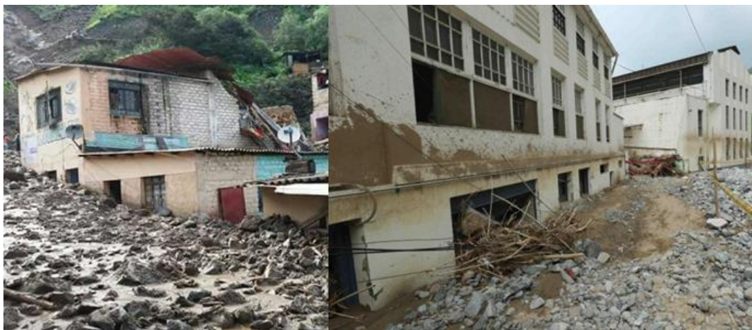
Figura 46: Viviendas e instalaciones de la central hidroeléctrica Barba Blanca, sepultadas por lodo y rocas (Diario El Comercio. 26/03/2017)
