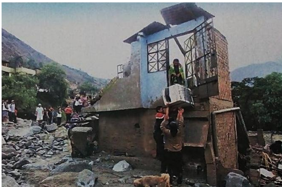
Chosica, 25/03/2015: Restos de lo que fue una casa de dos niveles. La primera planta fue sepultada y la segunda destruida por las enormes rocas que cayó por la quebrada Corrales en el Asentamiento Humano Rayos del Sol (Diario El Comercio)
