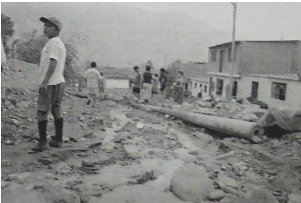
Figura 25: Calle destruida por flujo de lodo y rocas en el A. H. 3 de Octubre (Diario La República 15/02/1983)
