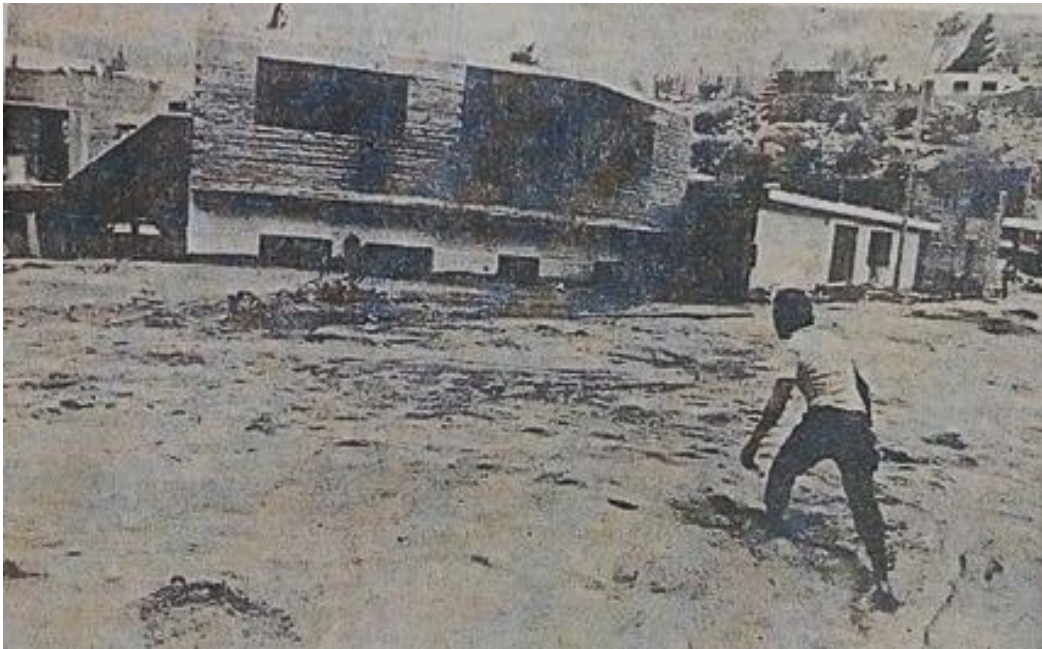
Huarochirí, 07/03/1983: El primer piso de una vivienda de dos plantas quedó sepultada por el lodo en el distrito de Santa Eulalia. (Diario El Comercio)
