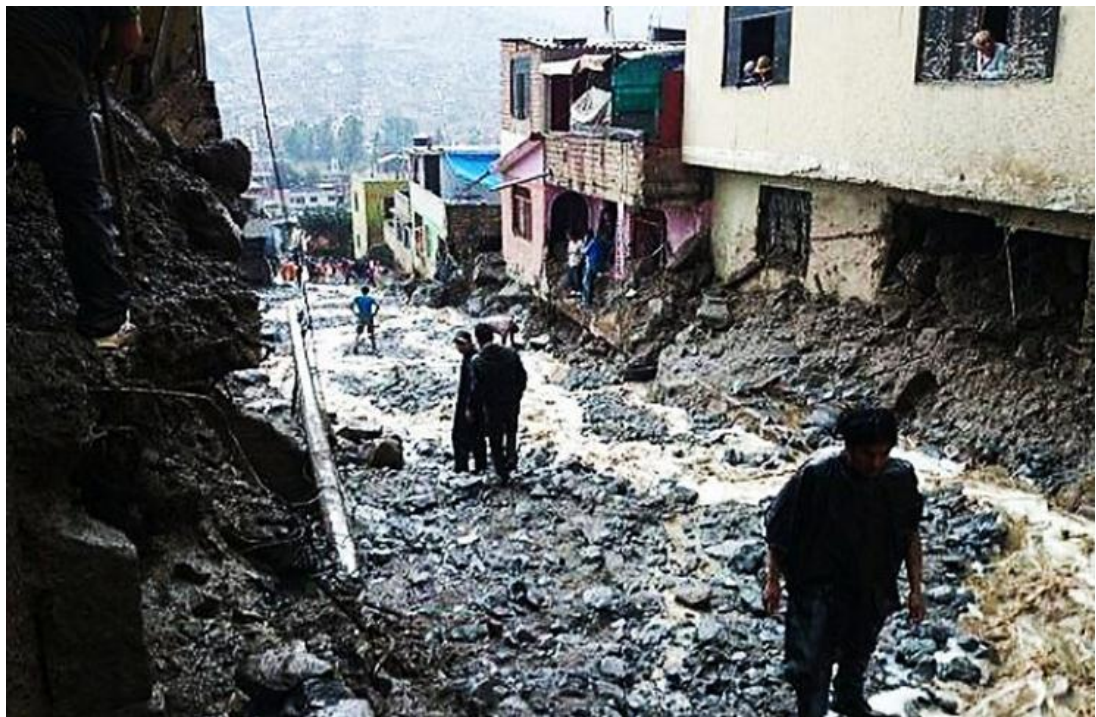
Chosica, 17/01/2017: Daños que dejó el paso del huayco en la quebrada Carosio en la ciudad de Chosica. Fuente: Diario El Popular 2017.
