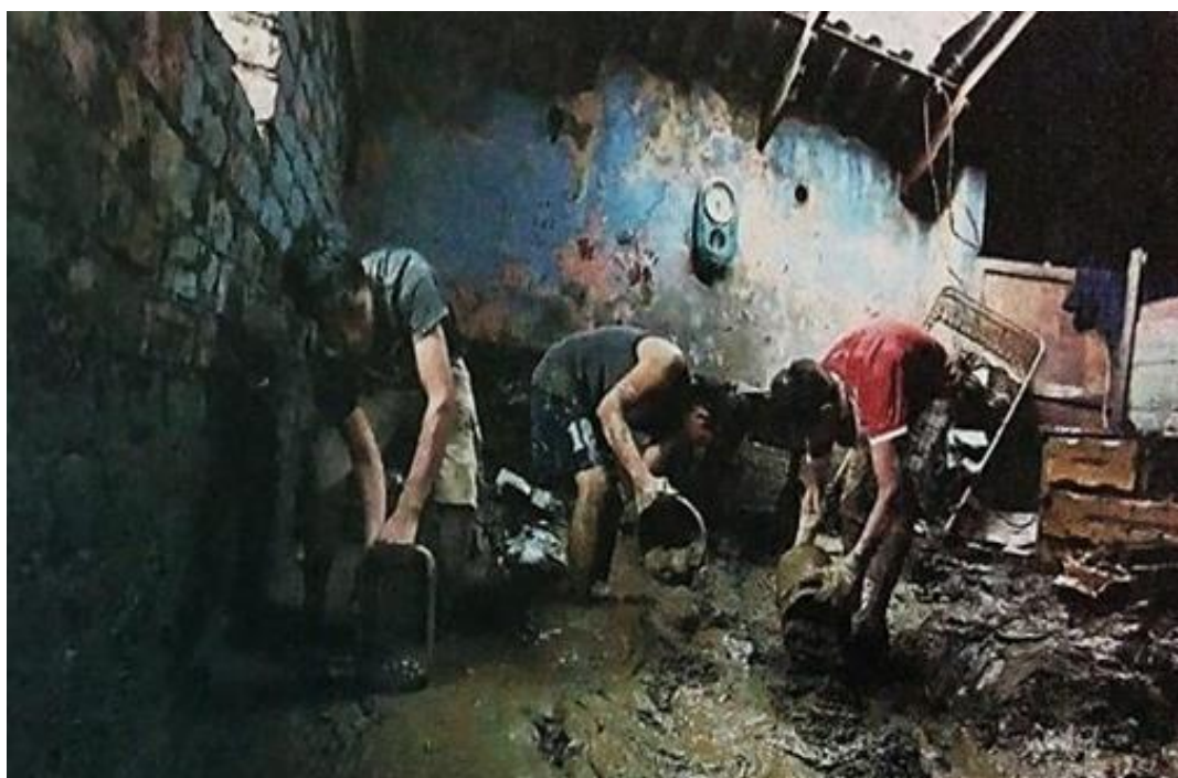
Chosica, 29/03/2015: 343 viviendas afectadas en el Asentamiento Humano Rayos del Sol. Se observa a los pobladores sacando con baldes el barro de su vivienda (Diario El Comercio)
