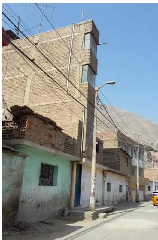
Fotografía N° 34: Viviendas con una configuración geométrica irregular en elevación. En el lado izquierdo una vivienda que no tiene proporción de base con altura y la segunda con escalonamientos abruptos (Fuente: propia)
