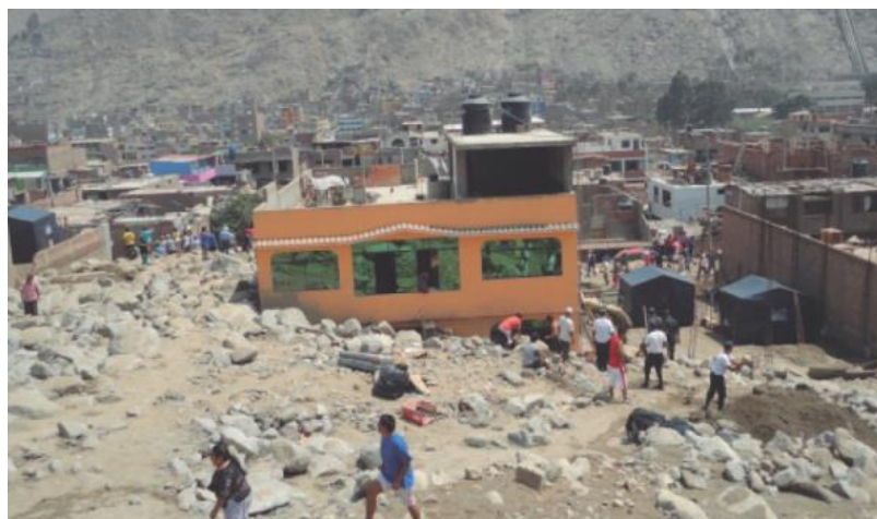
Fotografía N° 10: Flujo de detritos en la quebrada Mariscal Castilla (Guadalupe y Carrillo, 2012)
