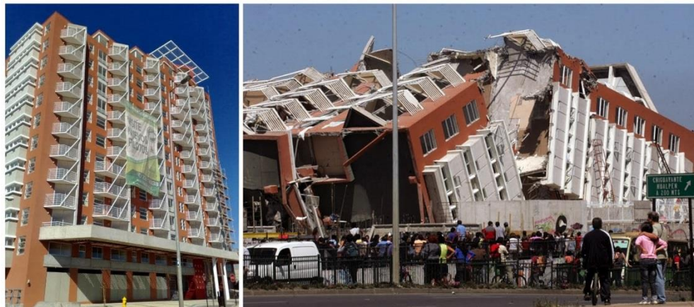
Fotografía N° 42. Edificio desplomado después del sismo en Chile del 2010 (Rendón, 2014)
