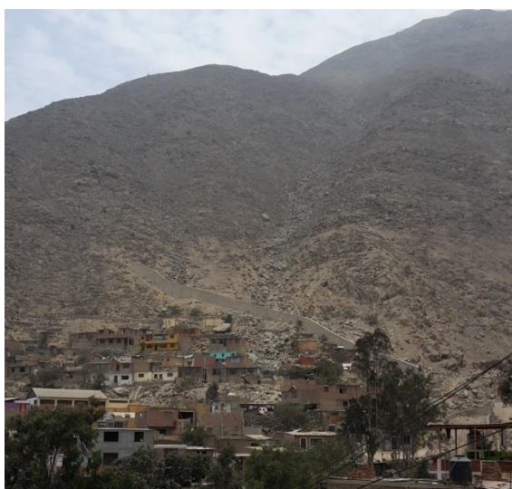
Fotografía N° 23: Zona de peligro muy alto en el AA.HH. Santo Domingo (Fuente: propia)
