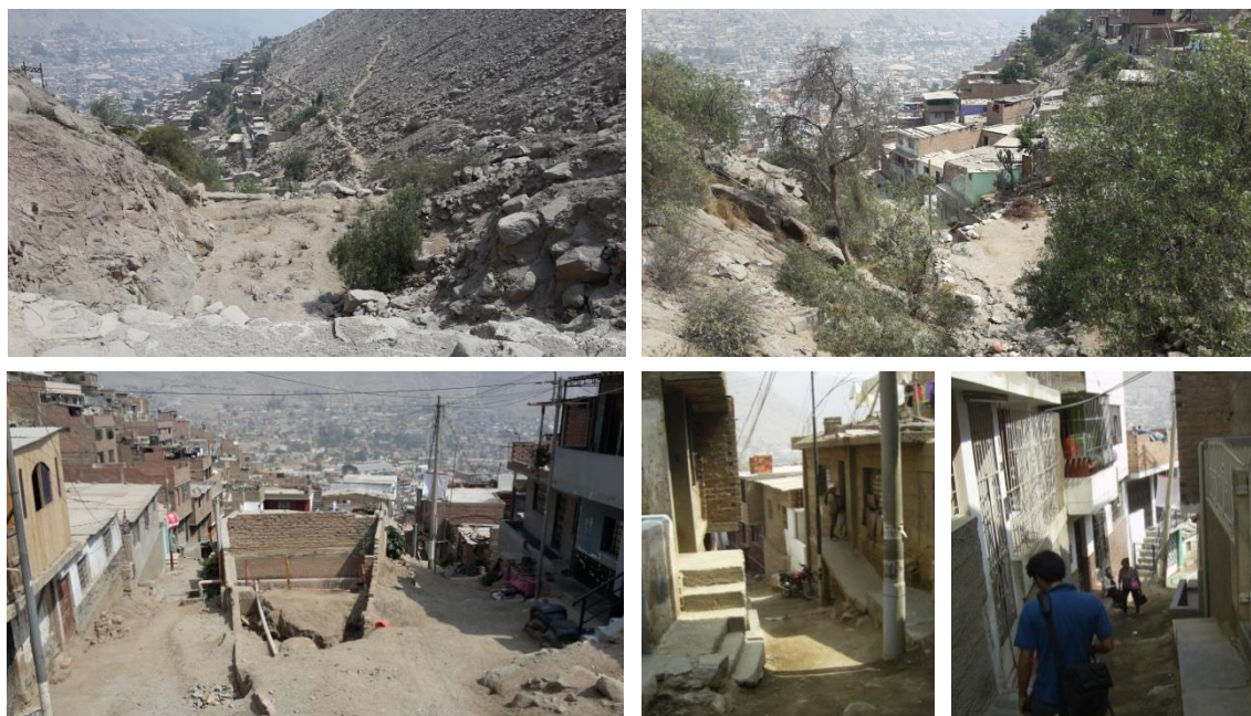
Fotografía N° 18: Trayectoria de la quebrada Libertad (Fuente: propia)
