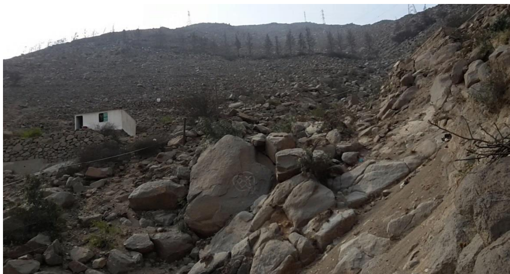
Fotografía N° 28: Grandes bloques de rocas en un torrente en la Asoc. Buenos Aires Comité 1 (Fuente: propia)
