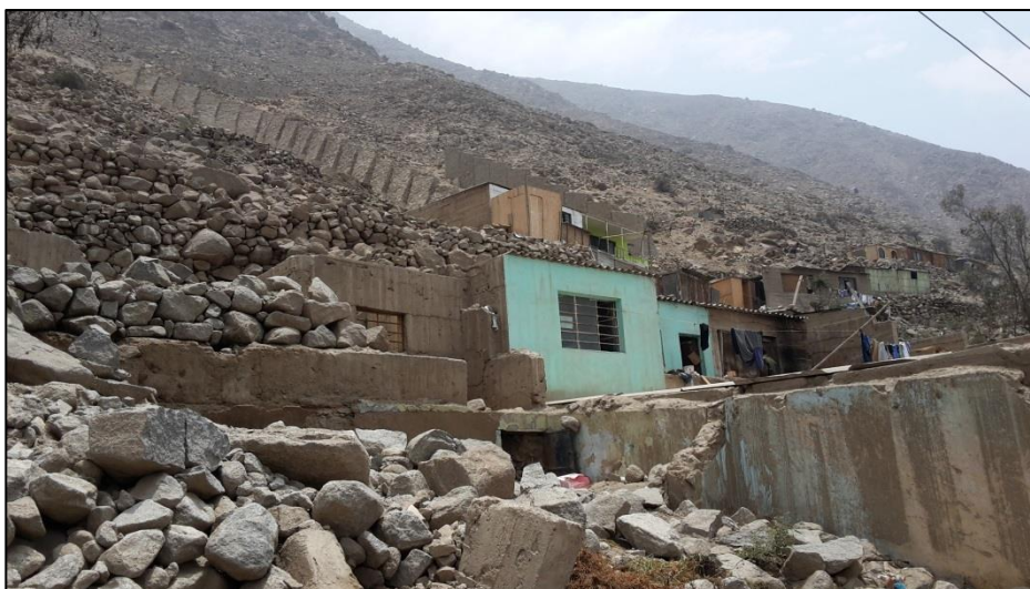
Fotografía: Viviendas destruidas por los flujos de detritos de Abril del 2012 en el AA.HH. San Juan de Bellavista
