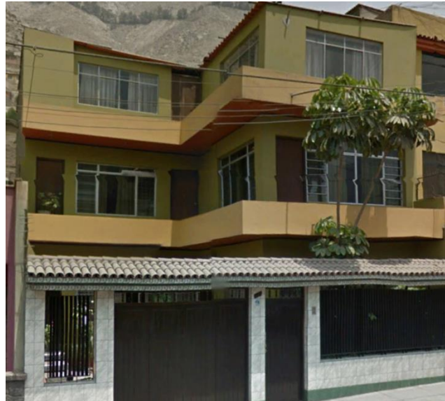
Fotografía N° 33: Vivienda con una configuración geométrica irregular en planta (Google Earth, 2014)
