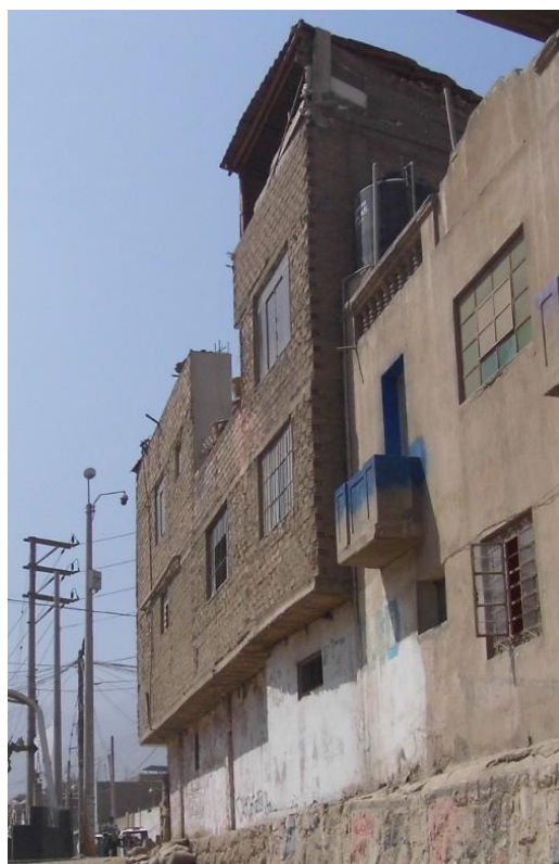
Fotografía N° 34: Viviendas con una configuración geométrica irregular en elevación. En el lado izquierdo una vivienda que no tiene proporción de base con altura y la segunda con escalonamientos abruptos (Fuente: propia)
