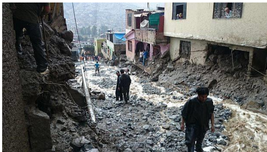
Fotografía N° 11: Viviendas afectadas en el cauce de la quebrada Carossio (El Comercio, 2015)
