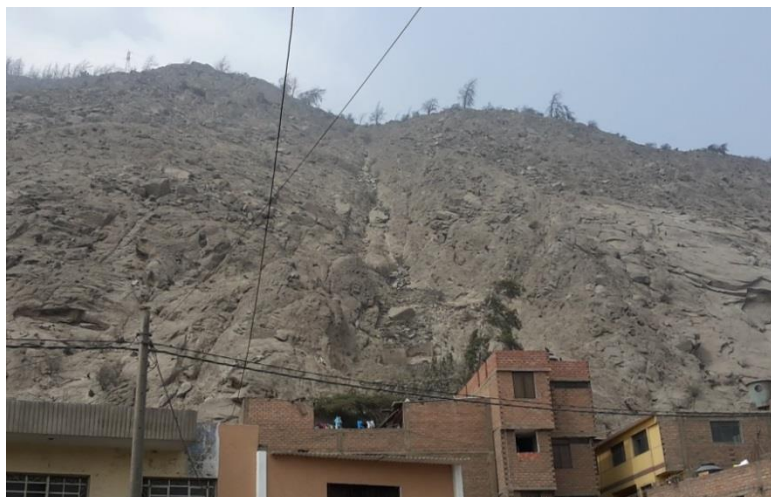
Fotografía N° 27: Viviendas bajo un cauce en el AA.HH. Comité Hogar Buenos Aires (Fuente: propia)
