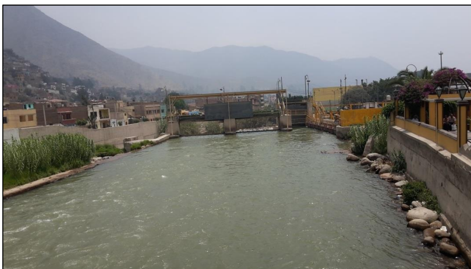
Fotografía: Desvío de las aguas del río Rímac hacia la hidroeléctrica de Huampaní
