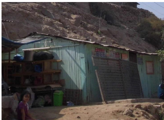
Fotografía N° 30: Vivienda de madera con un estado de conservación malo (Fuente: propia)
