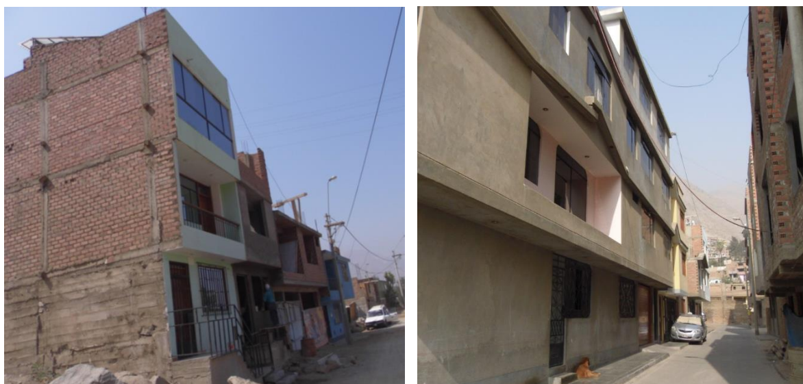
Fotografía N° 37: Presencia de volados, tanto en asentamientos humanos como en residenciales
