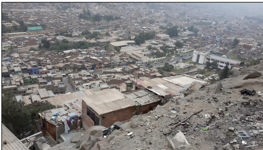
Fotografía: Hidroeléctrica de Moyopampa visto desde la parte alta de la Asoc. Comité Hogar Buenos Aires
